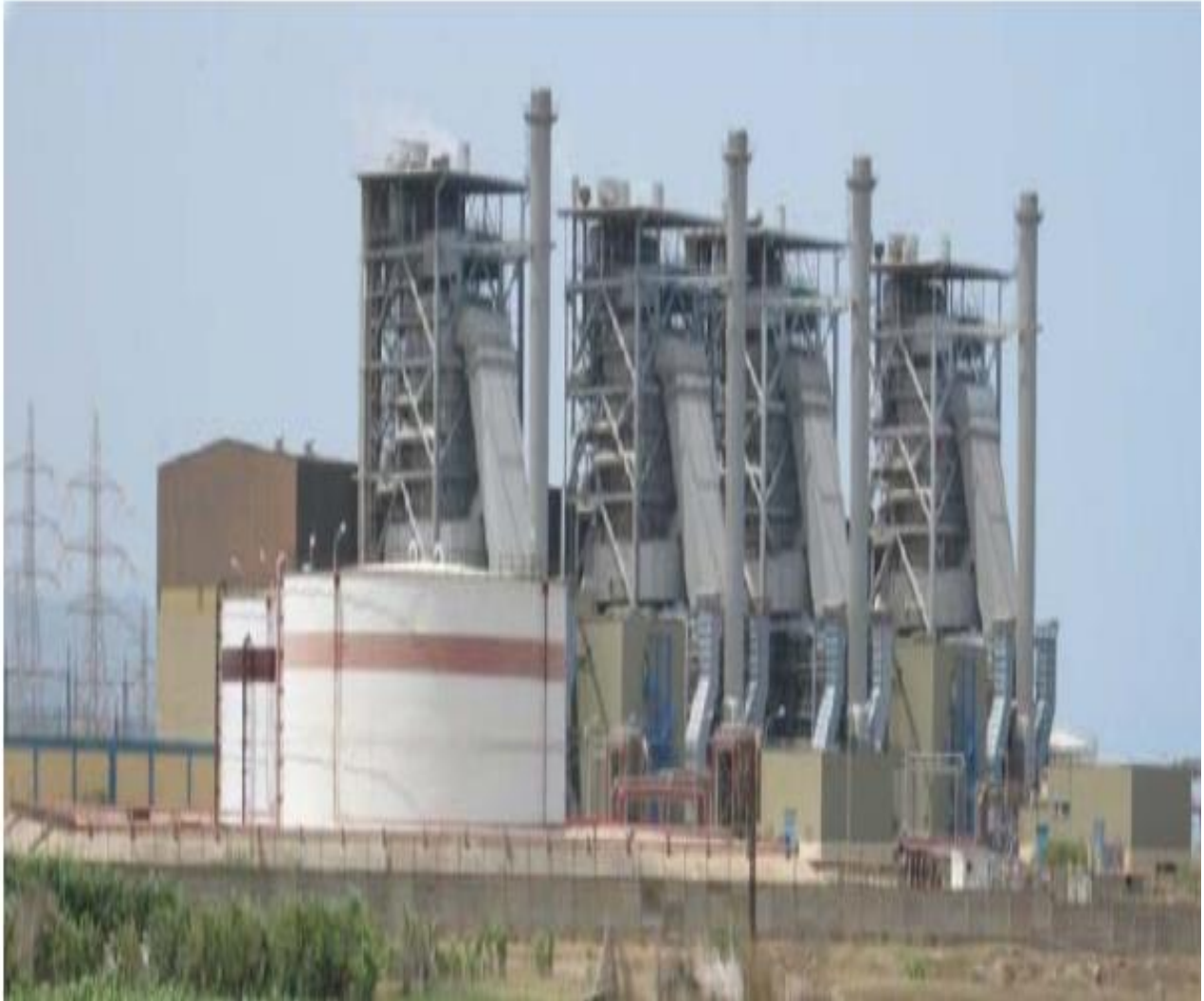
Figure 5 Central thermique de CAP- DJINET
