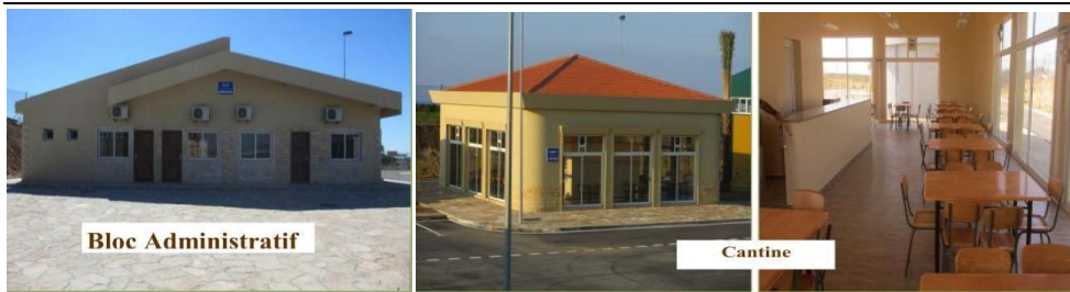
Figure N° 6 : Administration et cantine du CET de Corso
