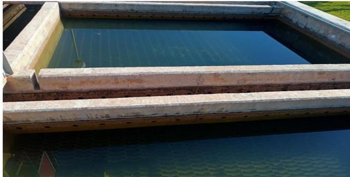
**Figure A.5.**Décanteur lamellaire.
