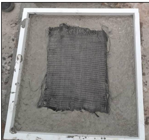
Figure III.27 : Pose du tissu CFRP
