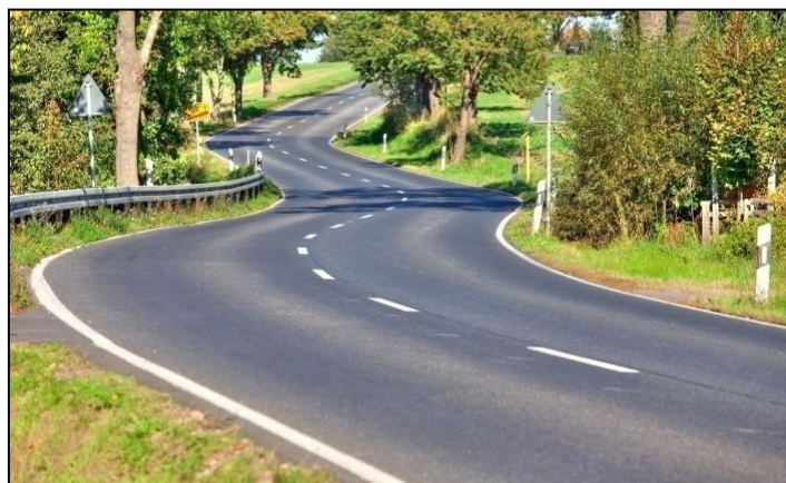
Figure I.2. Chaussée routière à double voies
