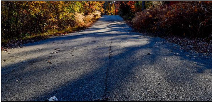
Figure I.16 : Fissures longitudinales
