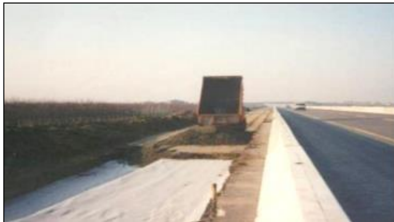
Figure II.23 : Un géosynthétique dans une construction routière [20]
