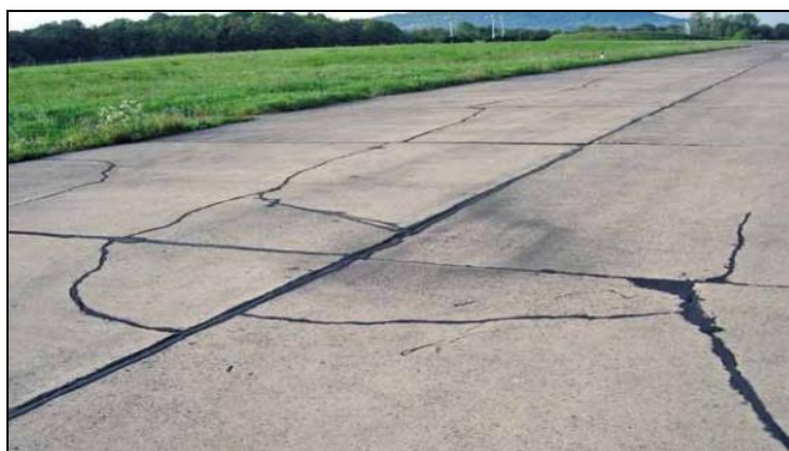
Figure I.26 : Pompage identifié par les dépôts de fines
