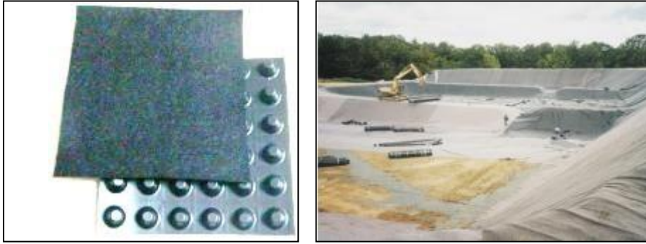
Figure II.10 (a) et (b) : Géomembrane- forme et sa mise en place [20]
