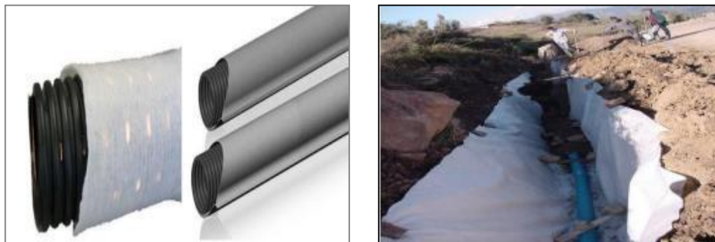
Figure II.5 (a) et (b) : Forme et mise en œuvre des géo-tuyaux [20]
