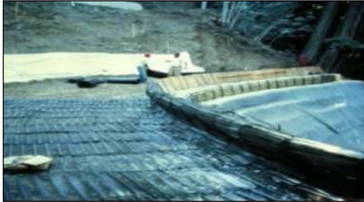
Figure II.24 : Un renforcement d'une pente par un géosynthétique [20]
