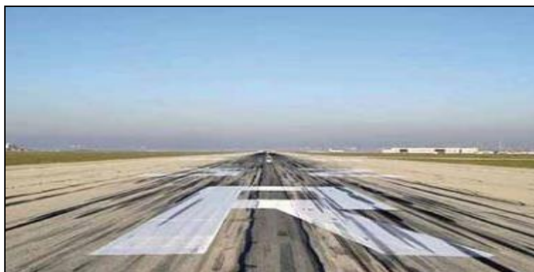
Figure I.33 : Dépôt de gomme au niveau de piste d'envol
