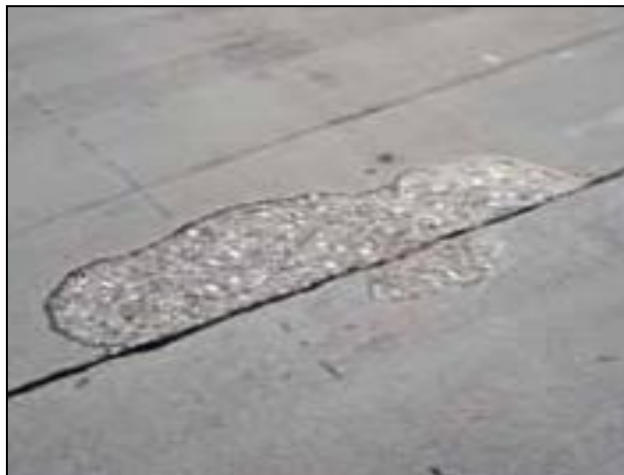
Figure I.30 : Vue d'Ecaillage.
