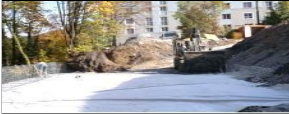
Figure II.1 : Nappe de géotextile et sa mise en place [20]
