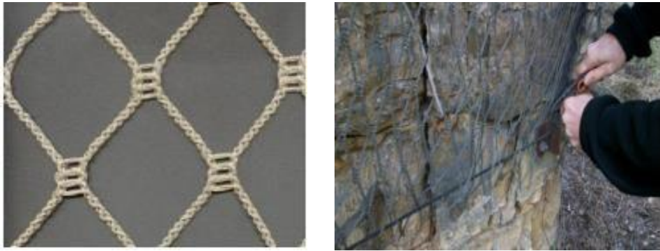
Figure II.14 (a) et (b) : Modèle de géo-filet et son placement dans un merlon [20]
