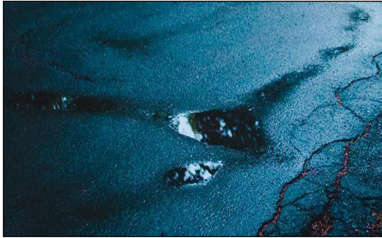
Figure I.14. Vue du tassement ‘flaches’
