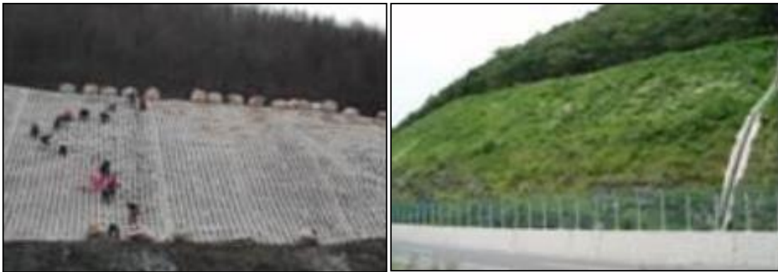
Figure II.29 : À gauche contrôle d'érosion sur pente, à droite travaux achevés [20]
