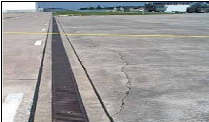
Figure I.23: Fissure longitudinale
