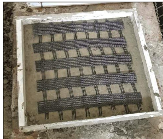
Figure III.26 : Pose de nappe géogrille
