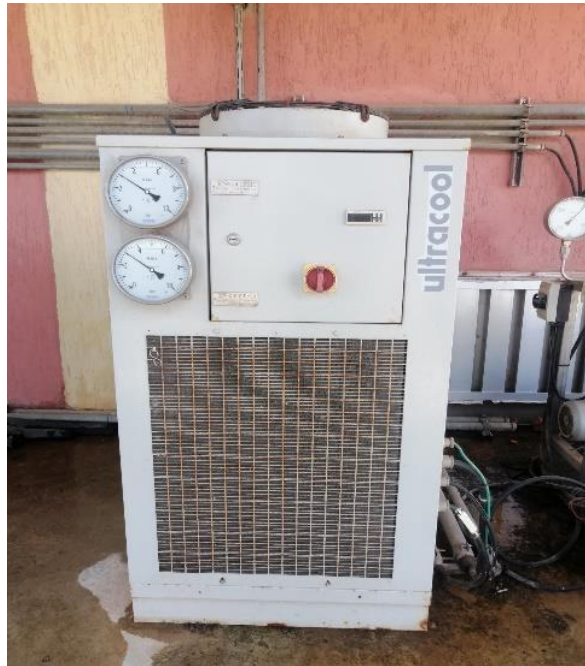
Figure III.16. Refroidisseur de l'électrolyte et du compresseur
