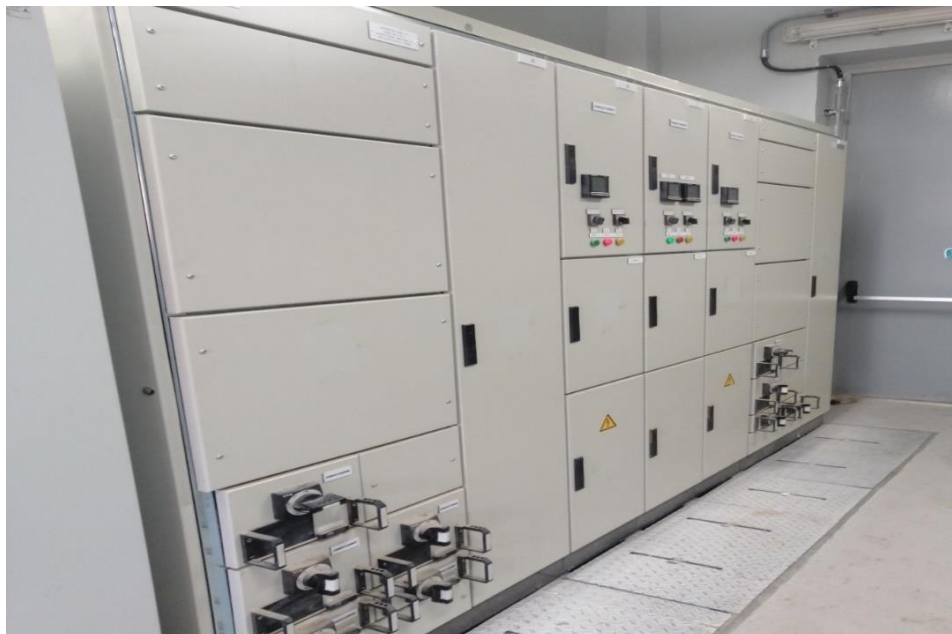
Figure III.24. Le centre de commande du moteur (MCC) [15].
