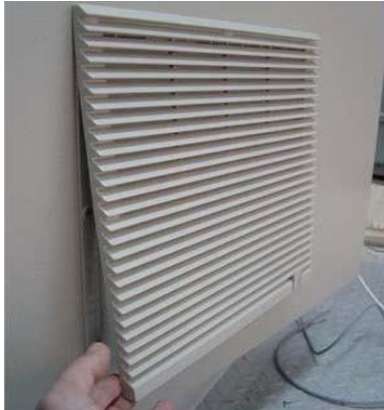
Figure V.12. Démontage des couvercles du filtre
