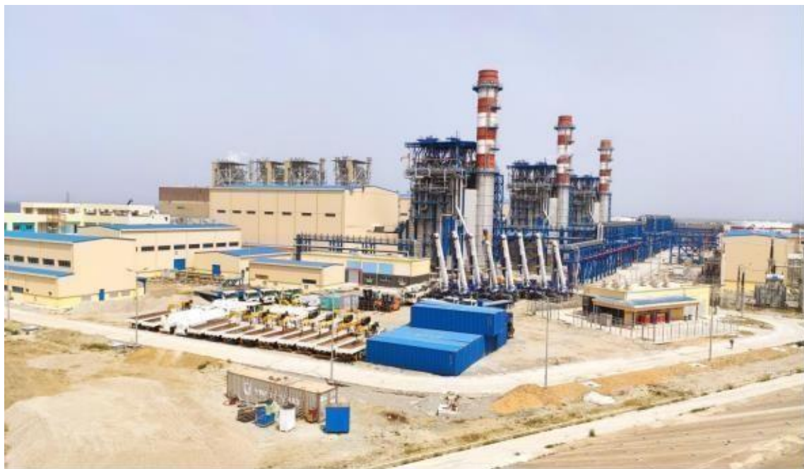
Figure I.2. Vue de la centrale Thermique de CAP-DJINET.
