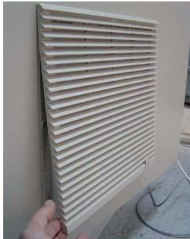
Figure. V .2. Démontage des couvercles du filtre
