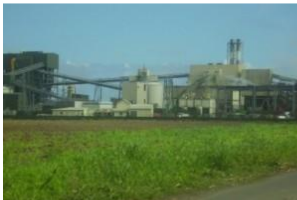
Figure 6 : Centrale à bagasse et à charbon pour la cogénération chaleur/électricité, Guadeloupe. (Photo : V. Paul, médiathèque EDF)
