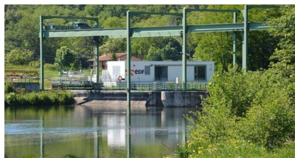
Figure 8 : Barrage de Grandval (Auvergne). Usine de lac. (Photo : C. Pauquet, médiathèque EDF)
