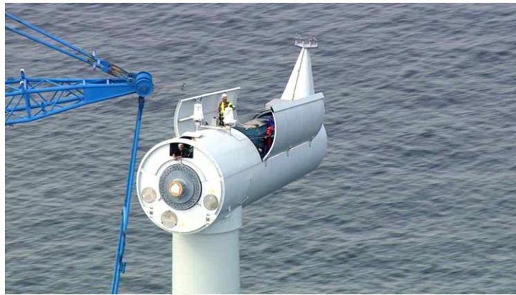
Figure 3. 11. Vue du ciel : Montage de la nacelle d'une éolienne en Action [9]
