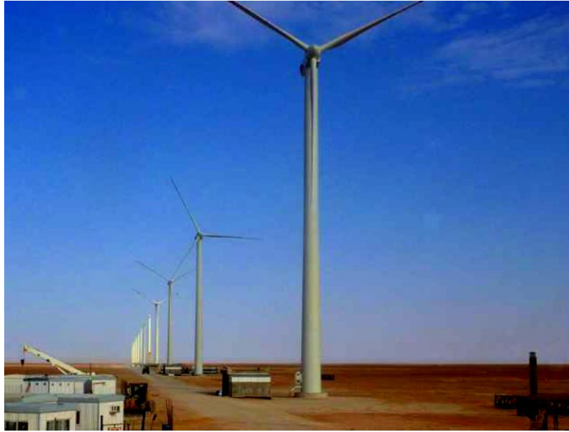
Figure 3. 4. Énergie verte à Kabertène (Adrar) : La Ferme Éolienne de 10 MW [5]
