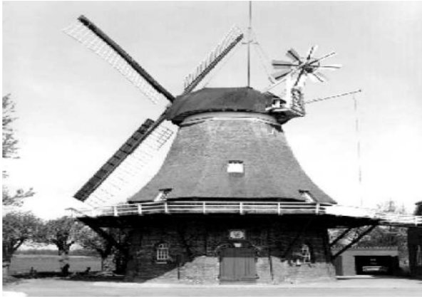
(c) Allemagne : Moulin à vent
