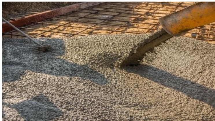
Figure I.1 : Béton à l'état frais [1]
