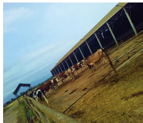
C : Bâtiment d'élevage
