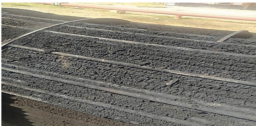
Figure IV-15 : faisceau tubulaire colmaté de l'échangeur 100-E1A.
