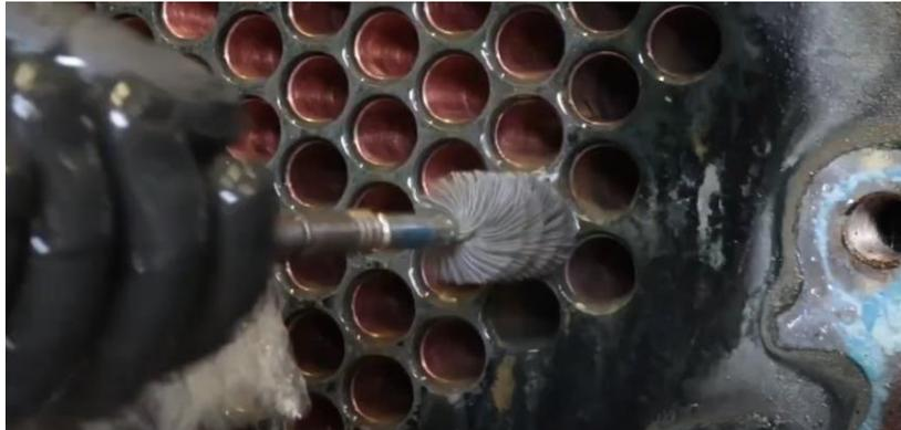
Figure III-3 : Nettoyage par un brosses rotatif.
