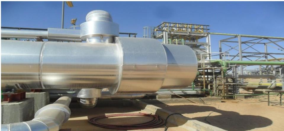
Deux filtres sont utilisés avant la boîte de distribution afin de réduire au minimum le dépôt de matière minérale.
