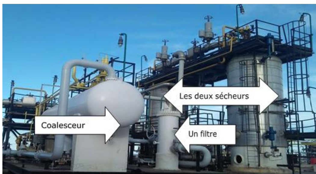
Figure II.3 : Section de déshydratation.
