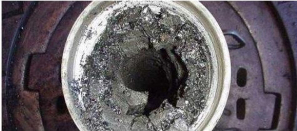
Figure II. 3: Un dépôt solide d'asphaltène se trouve dans un pipeline.
