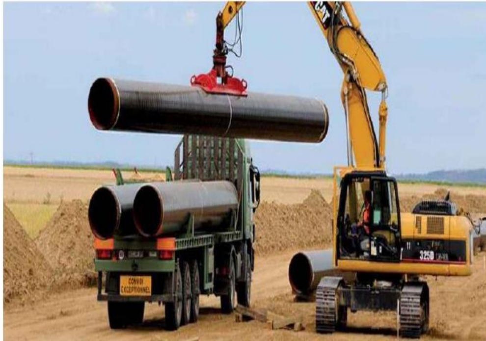
Figure II. 5: Déchargement des tubes sur piste.
