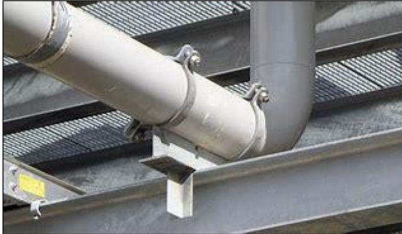
**Figure III-5 Exemple d'un tuyau supporter**
