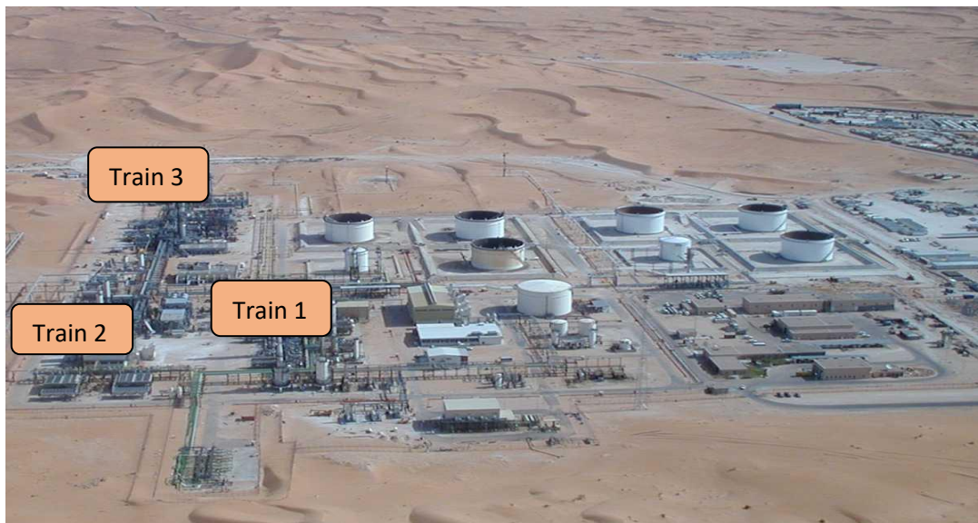
Figure 4-3 : Vue Aérienne de CTH.
