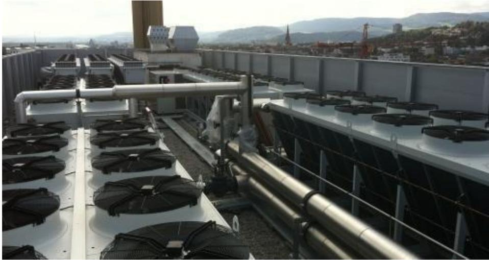
**Figure III.10:** Une série des aéro-réfrigérants
