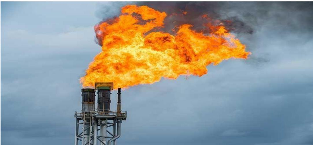
Figure IV.1 : Brulage des gaz torchés au niveau de la torche
