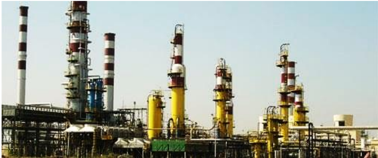
Figure I.6 : l'unité de distillation atmosphérique (U100)
