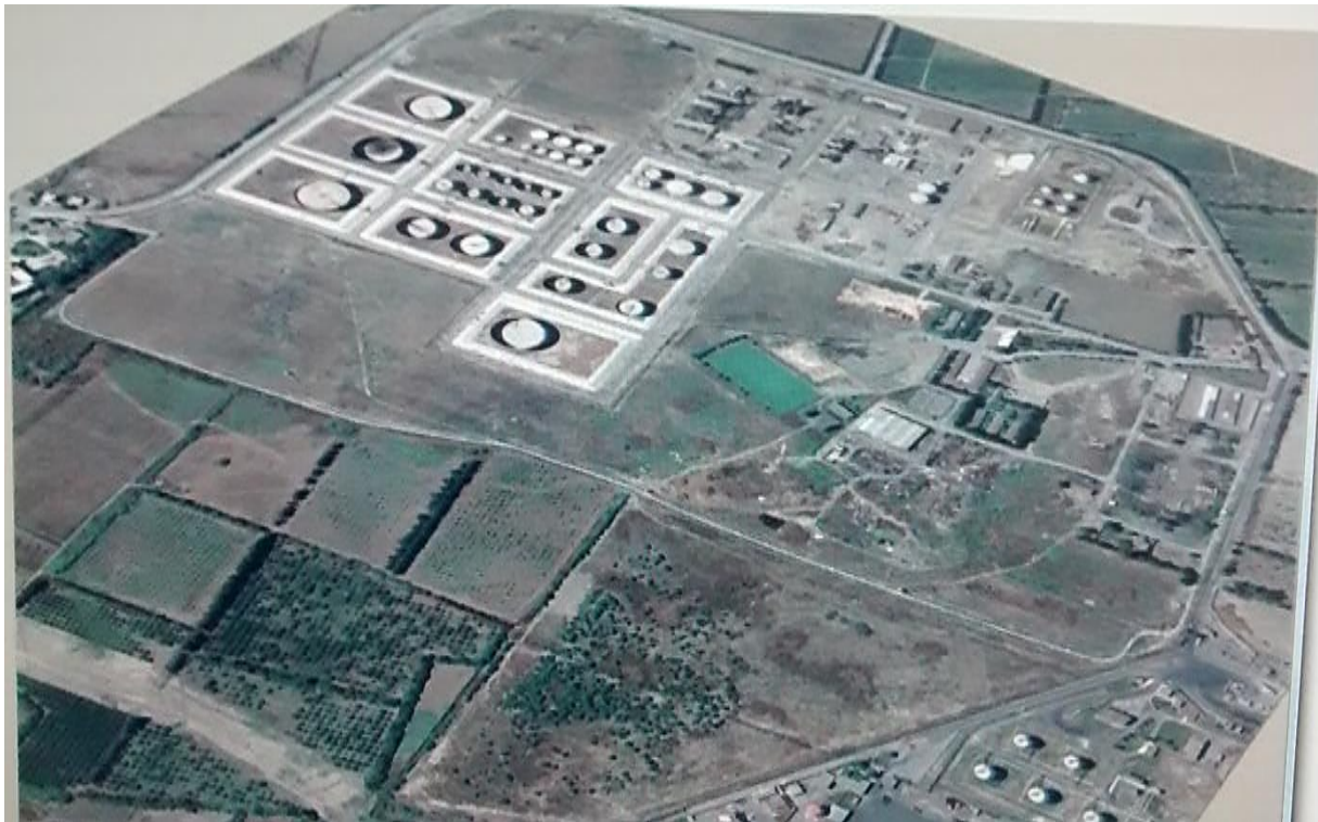
Figure I.3 : La raffinerie avant réhabilitation
