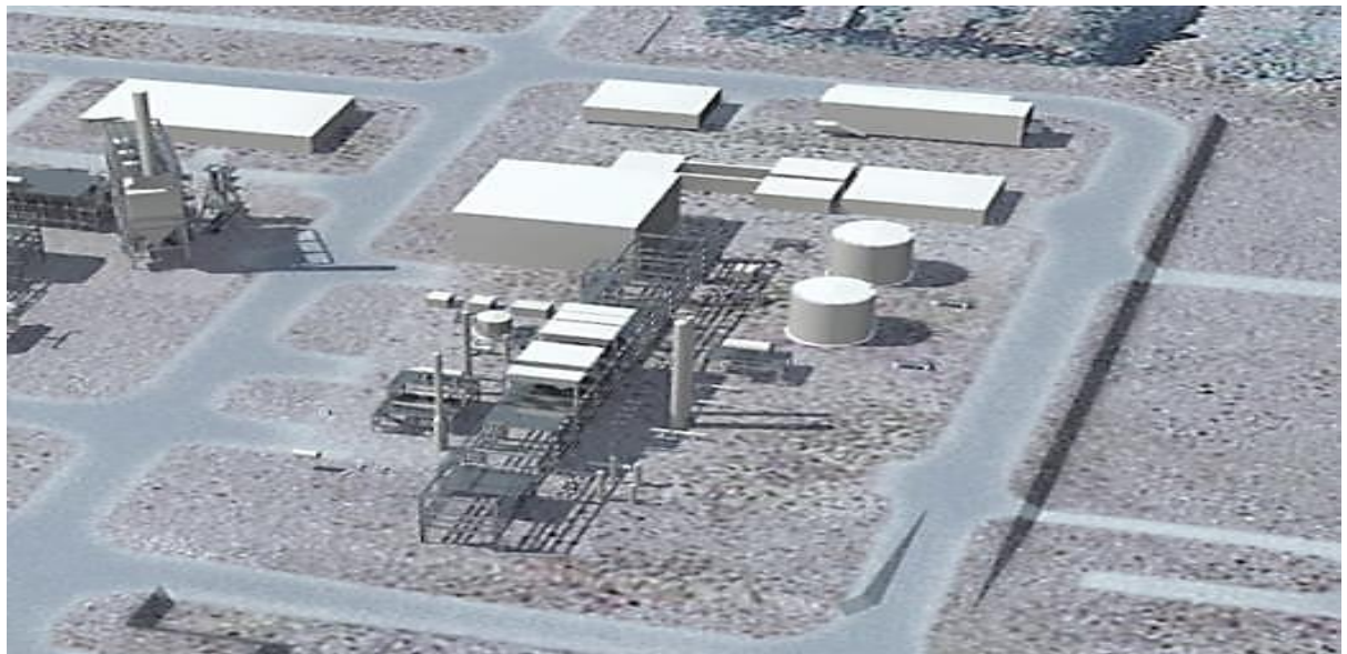
Figure I.13 : Unité Sulfur Block
