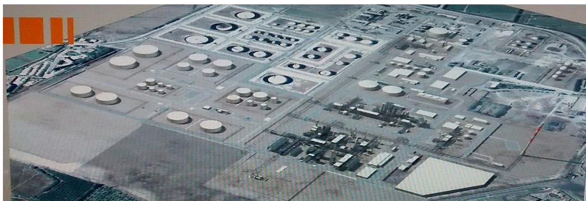
Figure I.4 : La raffinerie après réhabilitation
