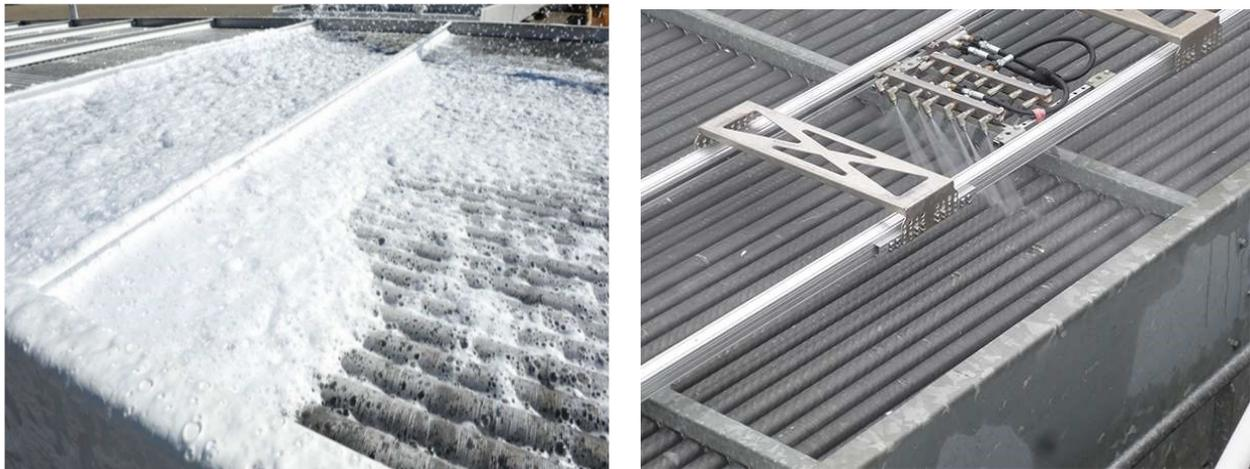
*Figure III-13 : Système de nettoyage de l'aéroréfrigérant*
