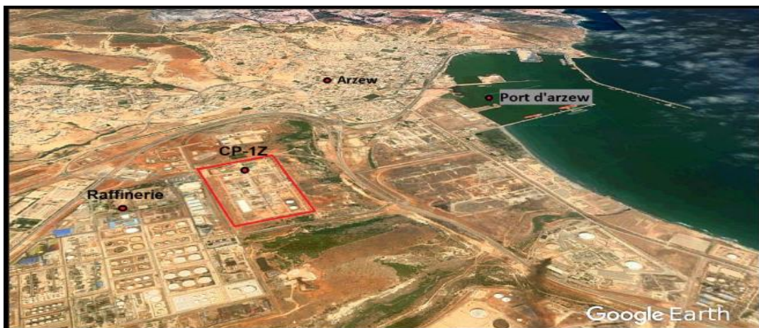
Figure 0.1 : Situation géographique du complexe CP-1Z [19]
