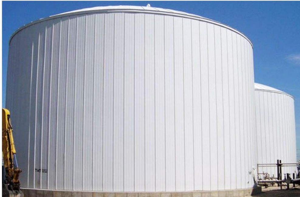
Figure II. 10 : Bac de stockage d'eau.
