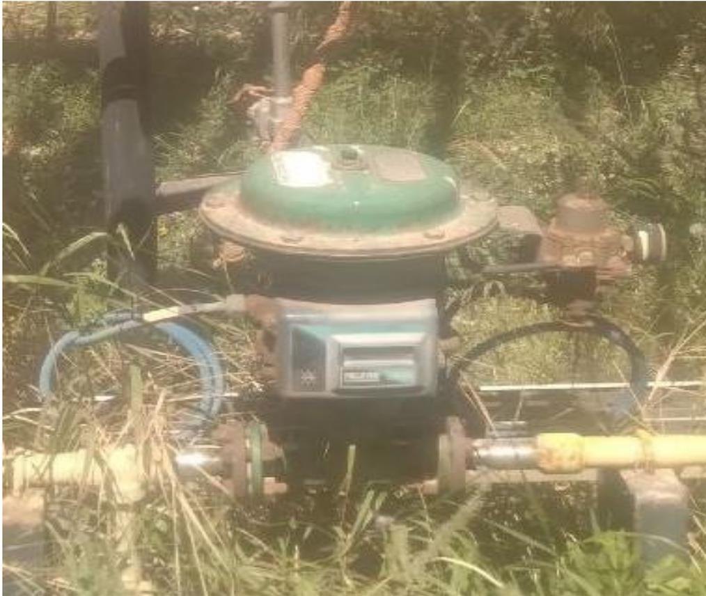
Figure III.3 Vanne de régulation de gaz
