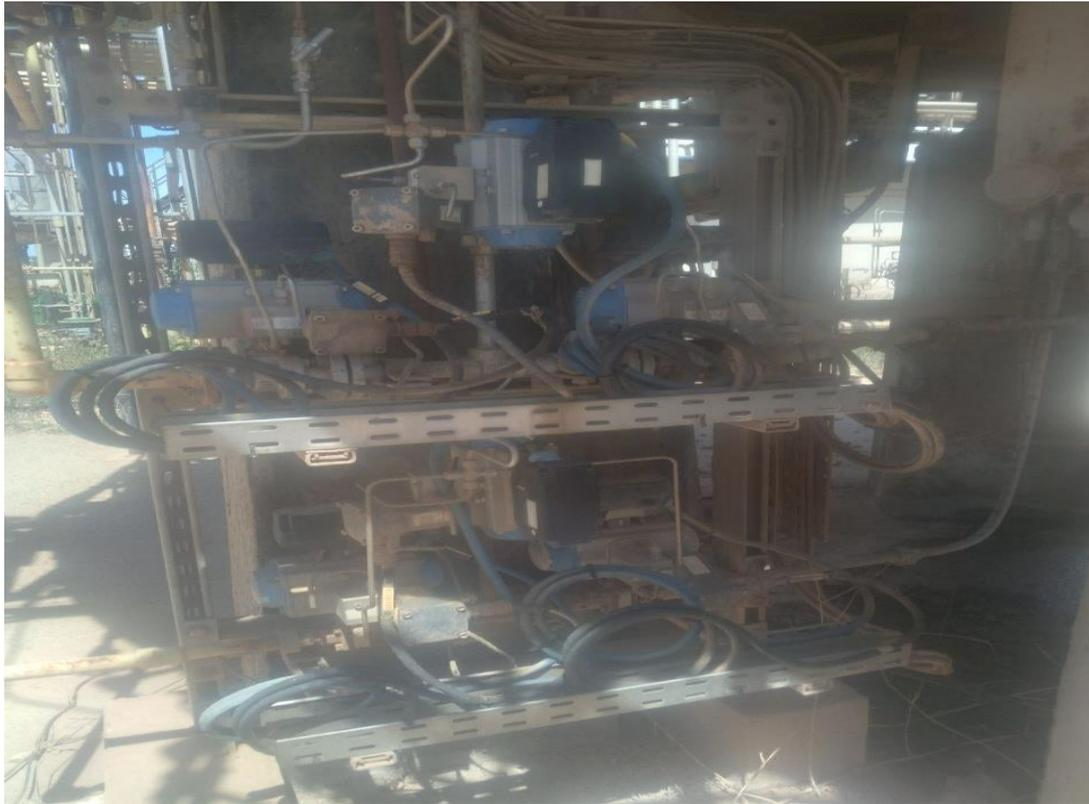
Figure III.2 les vannes de sectionnements et d'événements du Pilote et du Bruleur
