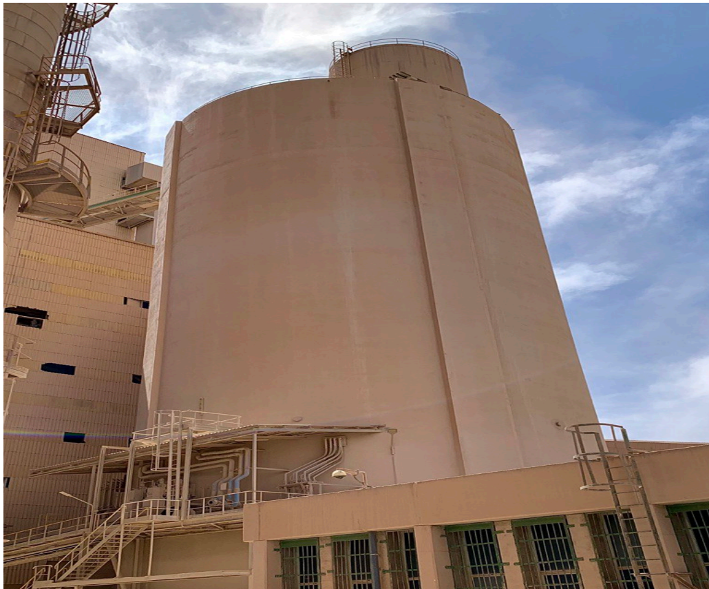
Figure II.1. Silo d'homogénéisation CPAG
