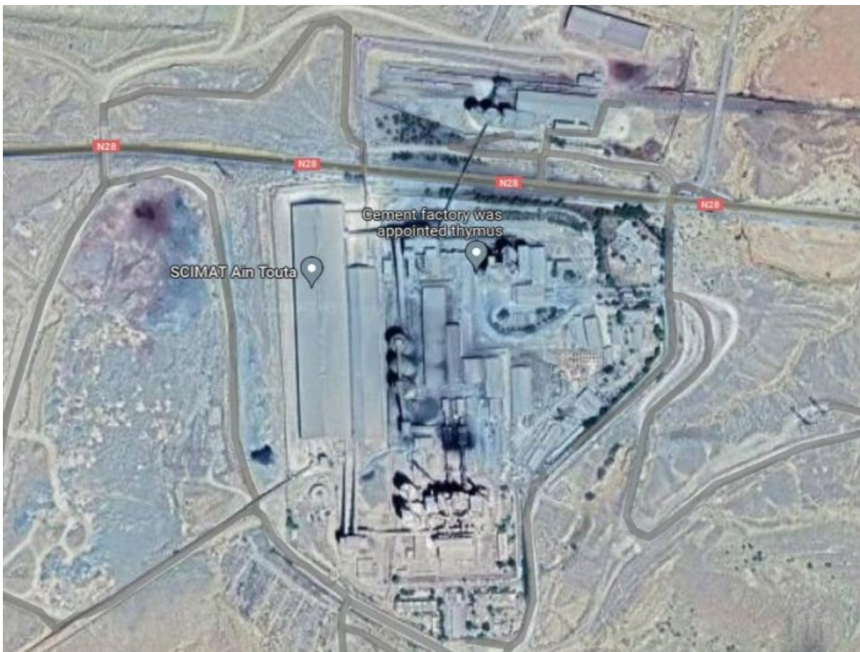
Figure I.1. Situation géographique de cimenterie Ain-Touta
