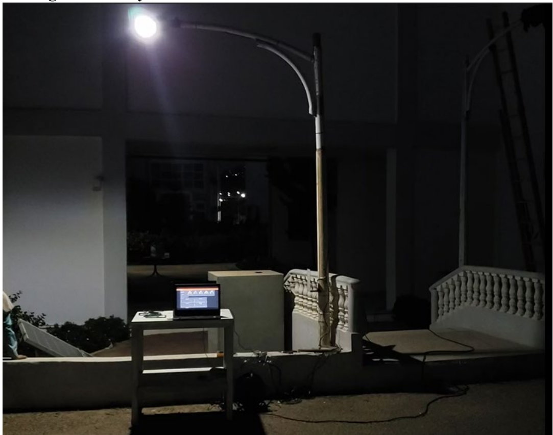
Figure IV. 24 Le système globale réalisé avec luminaire à niveau 20%.
