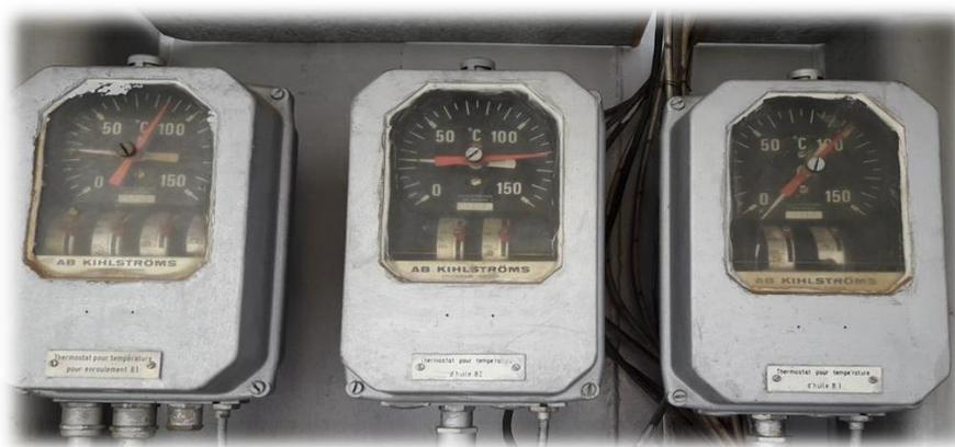
Figure IV.5: Thermostat pour température d'enroulement et d'huile.
