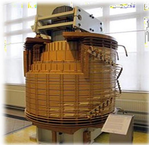
**Figure II.15 : Enroulements.**
