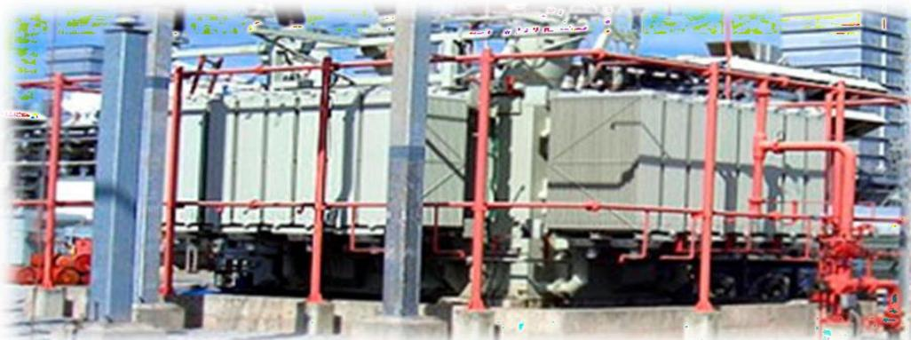
Figure IV.13 : Photo des protections incendie installé sur transformateur.
