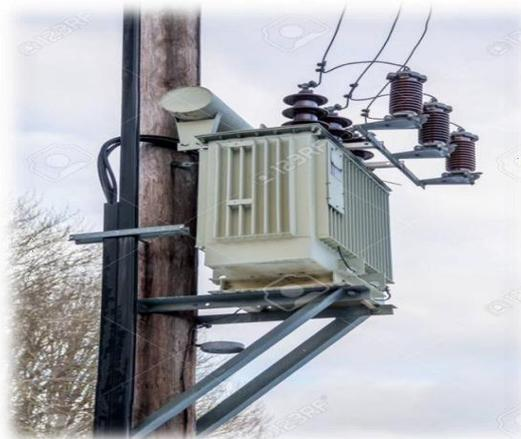
**Figure II.10 : Transformateur de distribution.**
