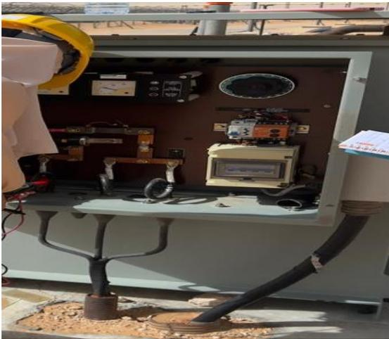
Figure III.2 Poste de soutirage simple
