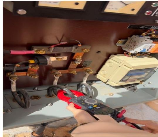
Figure III.3 La mesure du potentiel à l'aide d'un multimètre
