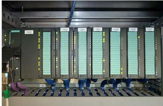
**Figure III.1** : L'automate programmable industriel [7]
