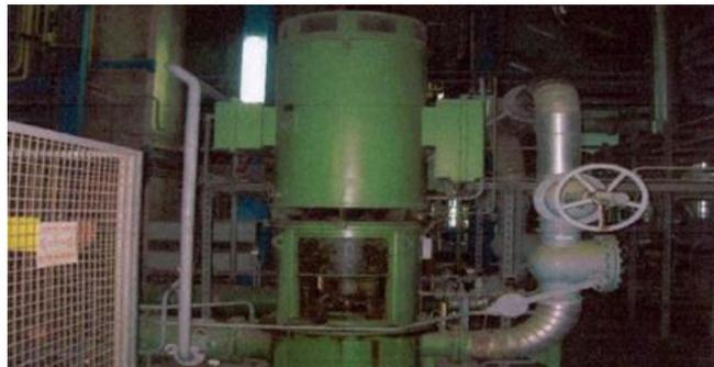
**Figure II.4 :** Vue de face de la pompe d'extraction.[35]
