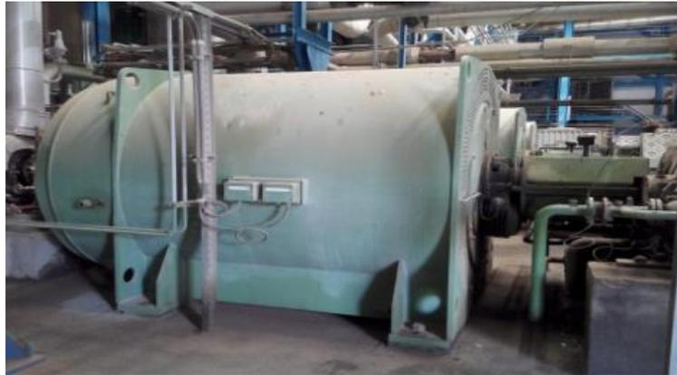
**Figure II.5 :** Vue de face de la pompe d'alimentation. [35]
