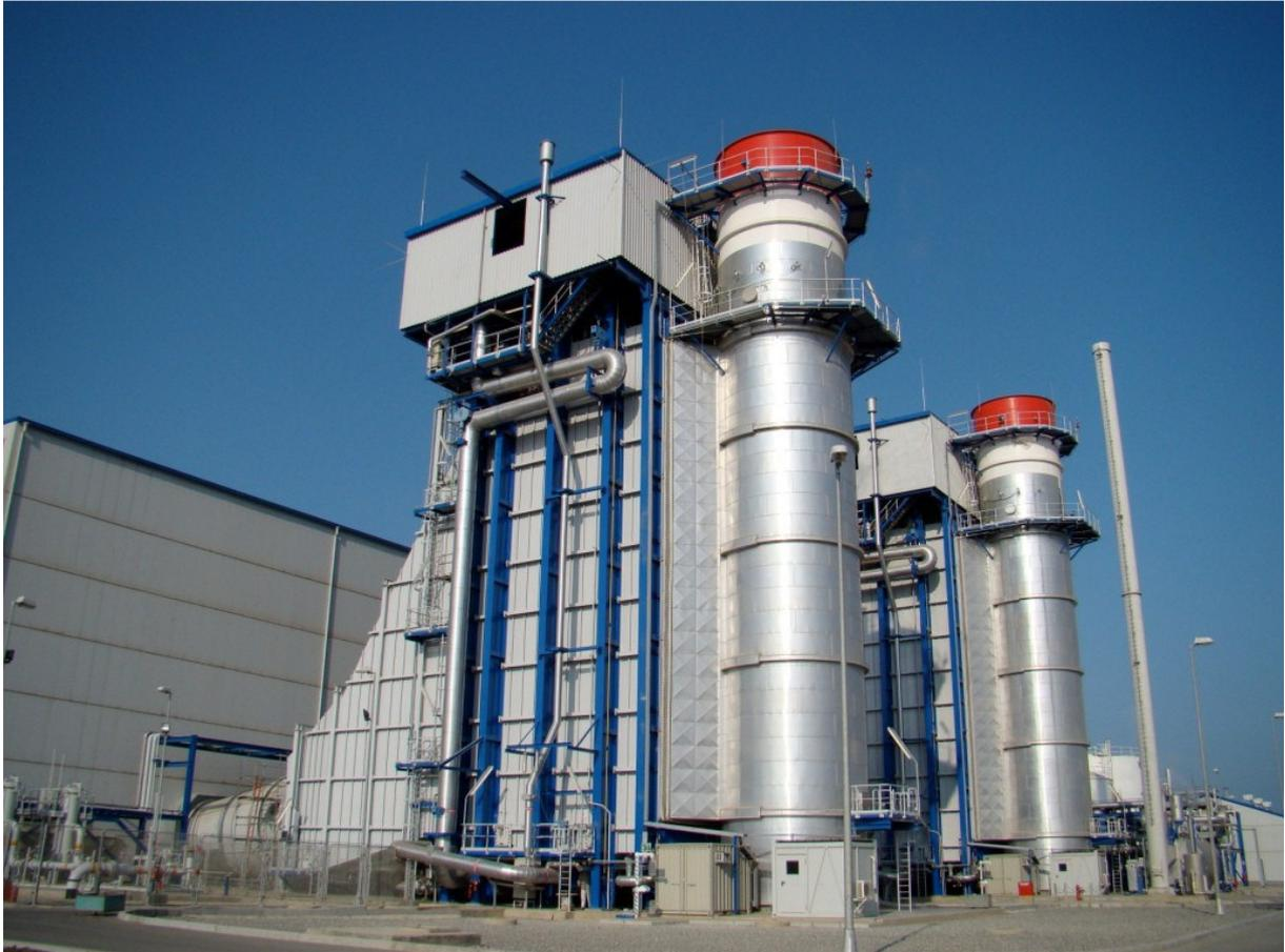
**Figure I-2 :** Vue de la chaudière de récupération.
