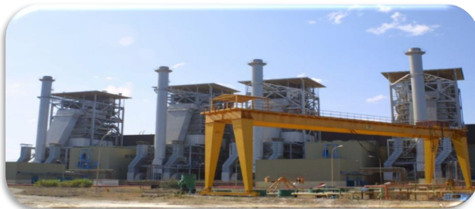
Figure [I.9] : générateur de vapeur
