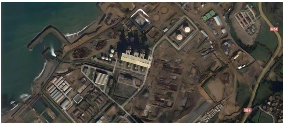
Figure [I.2] : localisation géographique de la centrale électrique de CAP-DJINET
