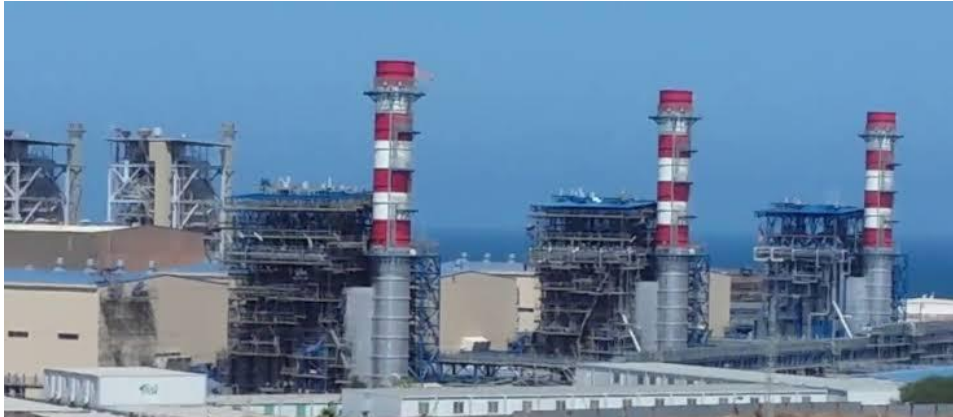
Figure [I.1] : centrale thermique de CAP-DJINET
