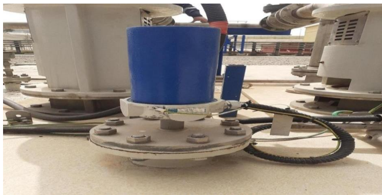
Figure [II.11] : Capteur de niveau
