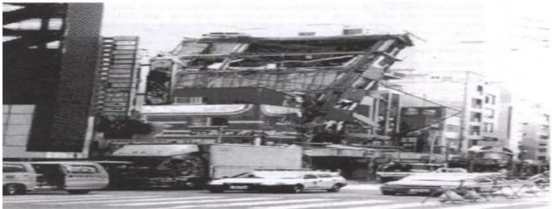
Figure 1.10.a : Dommages dus à des oscillations importantes de la structure (Séisme de Kobe, Japon ; 17 janvier 1995).
