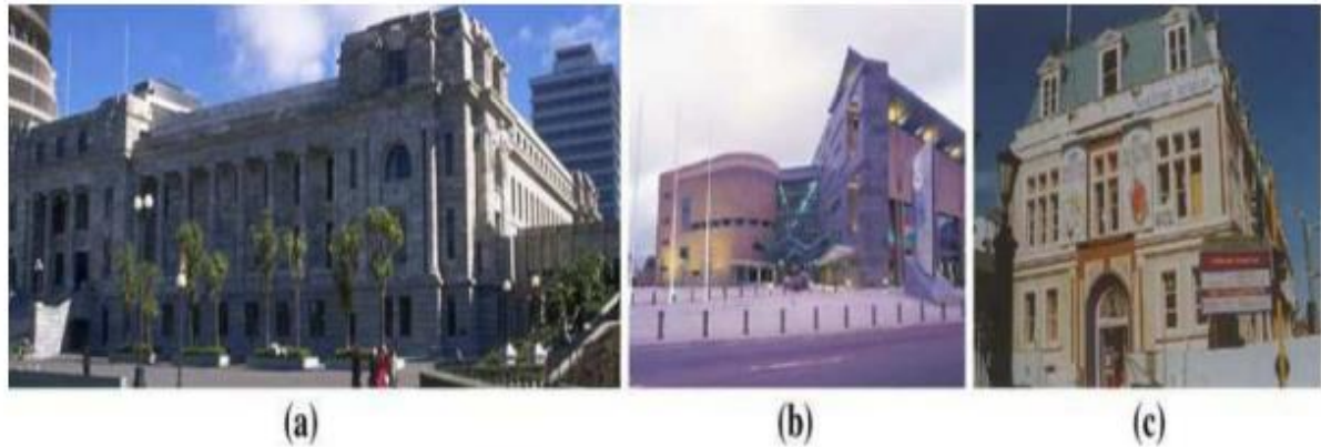
Figure 1.7: Bâtiments protégés par les systèmes d'isolation à Wellington (Nouvelle Zélande).
