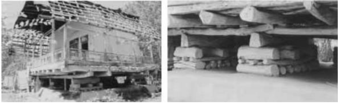
Figure 1.3 : Morceaux de bois installés entre la base et le palier des maisons en Iran.
