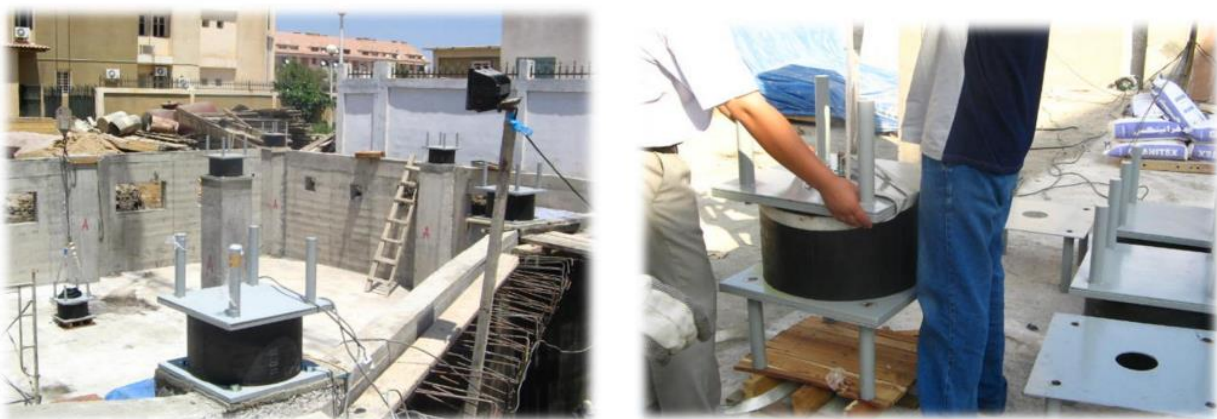
Figure 1.13.b : Installation des dispositifs parasismiques [11]
