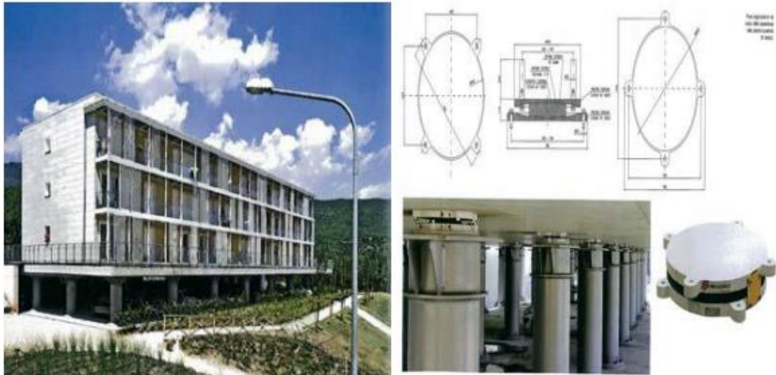
Figure 1.11.b : Aquila bâtiments du quartier et le système de pendule de frottement utilisés
