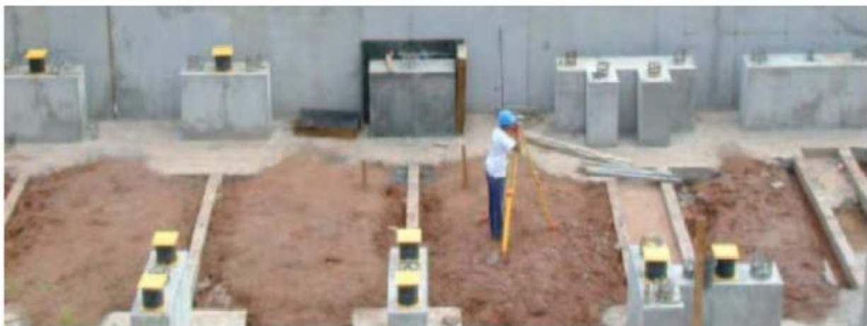
Figure 1.1 : implantation des appuis parasismiques
