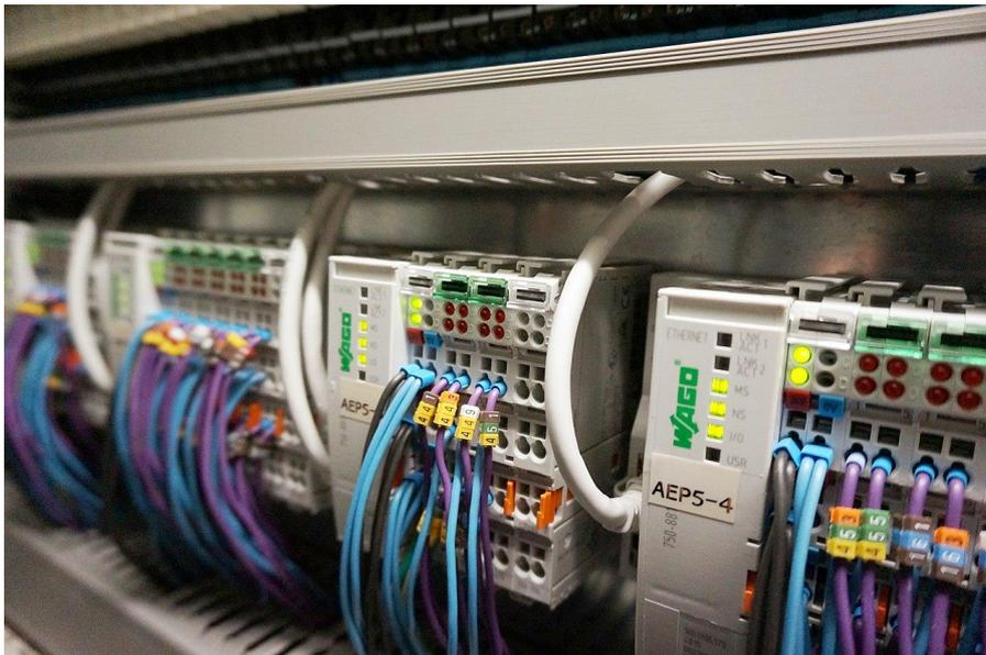
**Figure 3.3 :** Contrôleurs programmables logiques (PLC)
