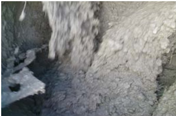
Malaxage du béton
