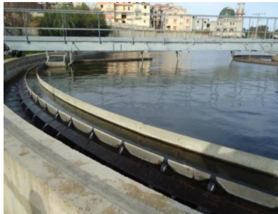
**Figure I.7 :** Récupération des eaux épurées du clarificateur par surverse.
