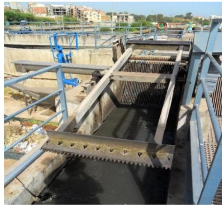
**Figure I.2 :** Dégrilleur.
