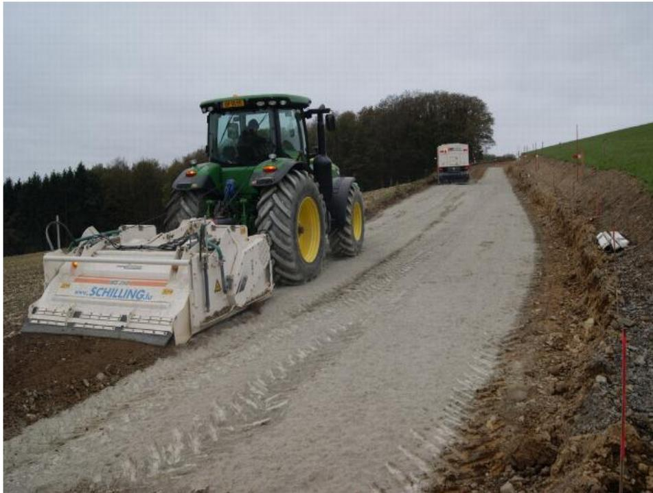
Figure III-8 : *exemple (1) sur stabilisation par ciment*
