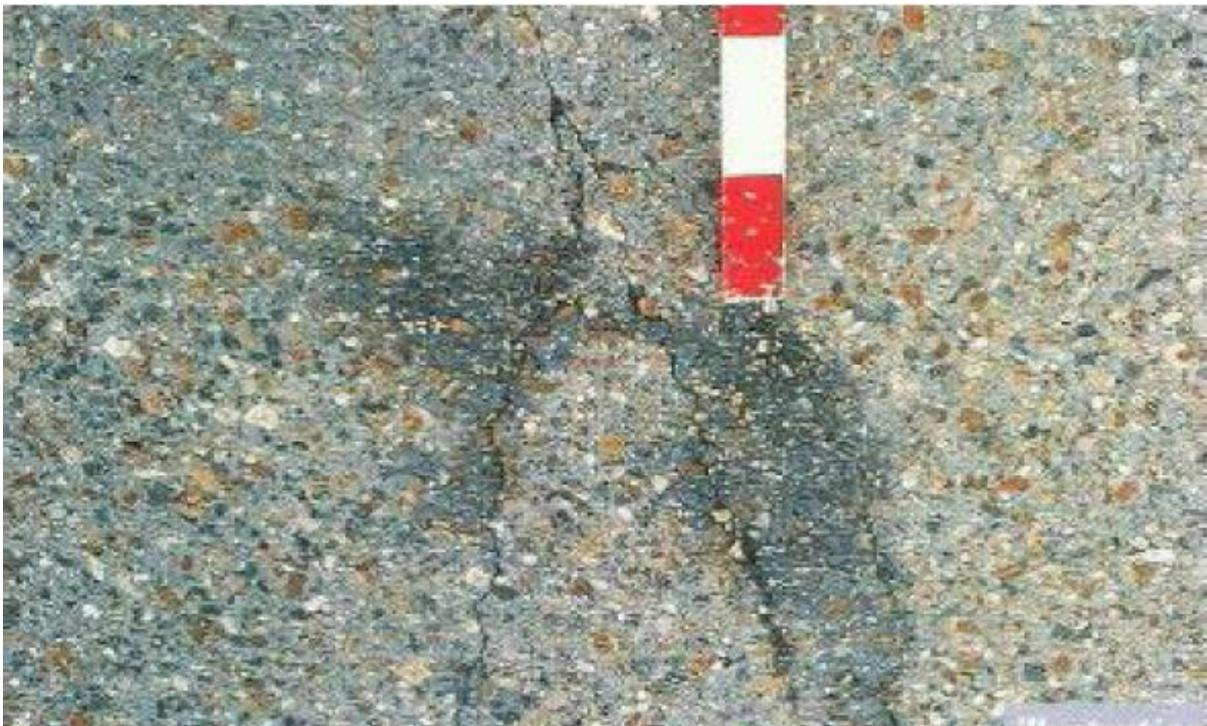
**Figure II-10 : Fissure diverse en Y**
