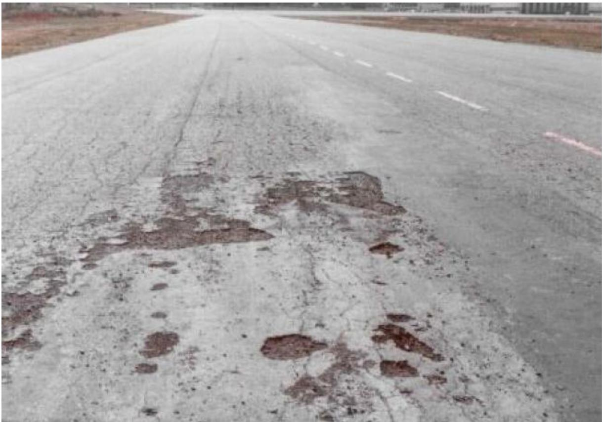
**Figure II-3 :** *Dégradation d'arrachement.*
