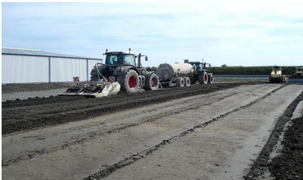
Figure III-9 : *exemple (2) sur stabilisation par ciment*
