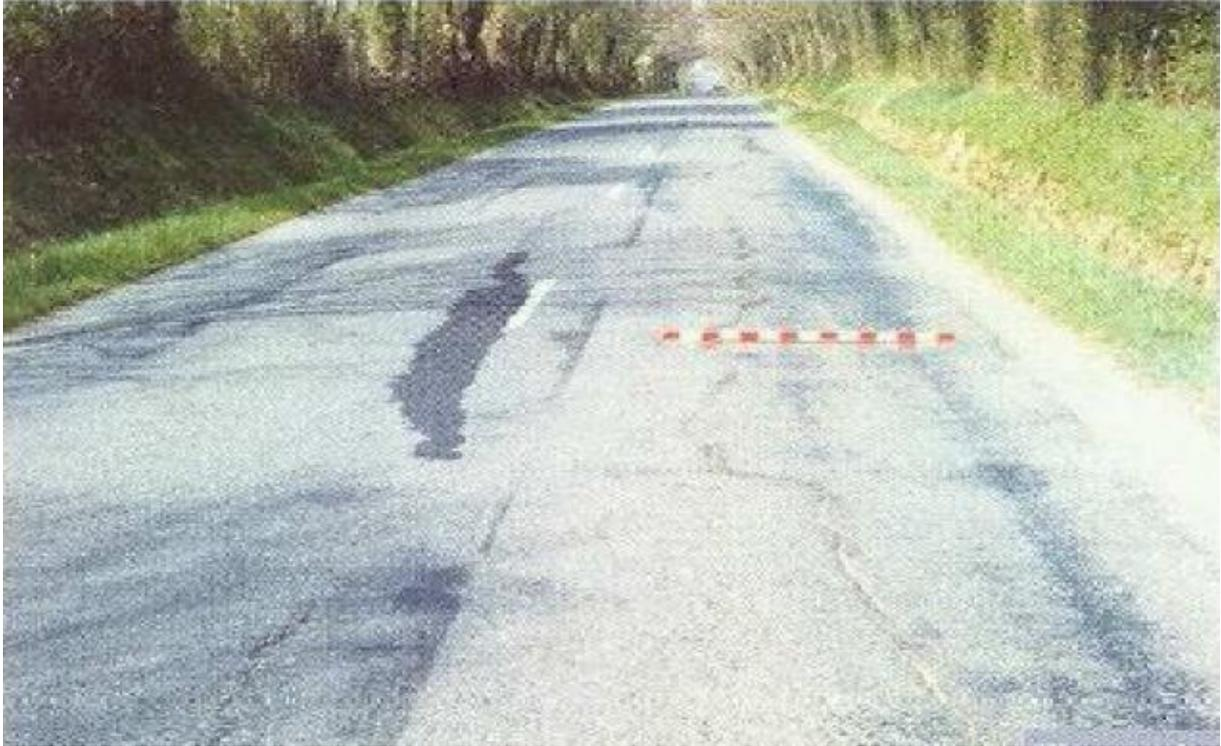
**Figure II-9 : Fissure d'adaptation**
