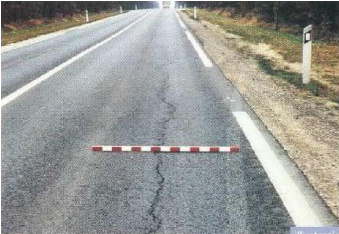
**Figure II-7 :** *Fissuration longitudinale.*
