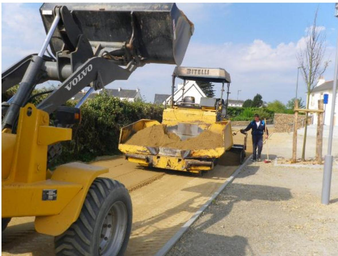
**Figure III-10** : *Stabilisation par ajout de sable.*
