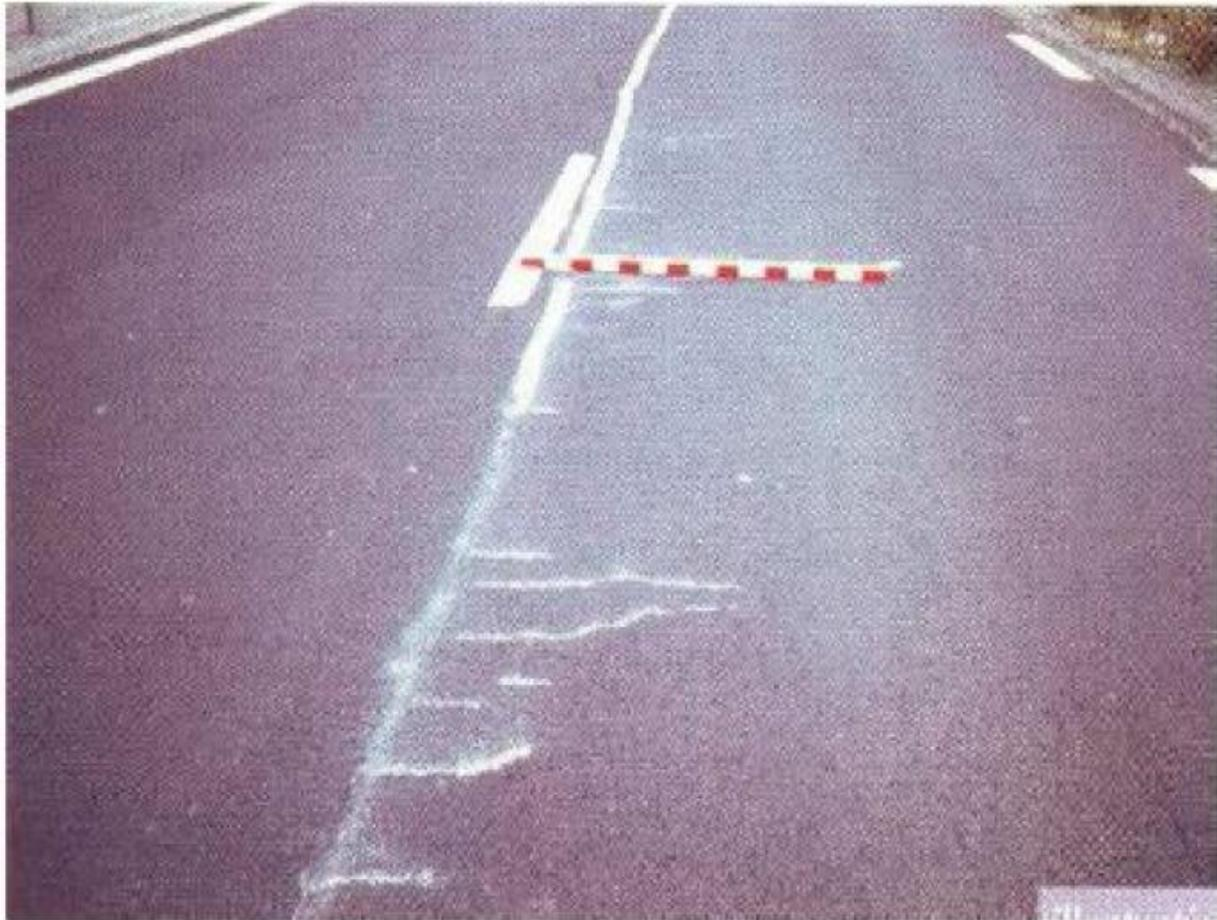
**Figure II-4 :** *remonté des fines*
