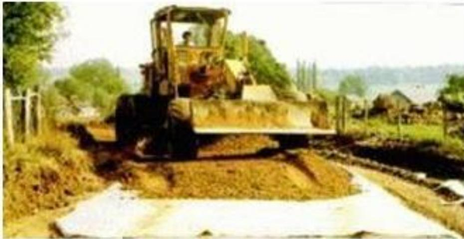
**FigureIII-1** : *Utilisation d'un géotextile*
