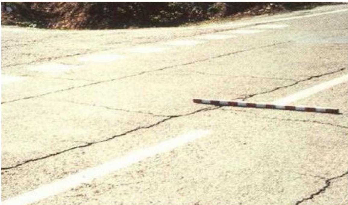
**Figure II-8 :** *Fissure en dalle.*
