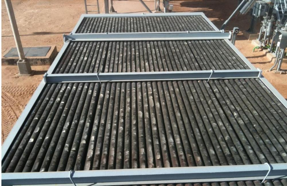
**Figure III.16. Faisceau tubulaire de d'aéroréfrigérant**
