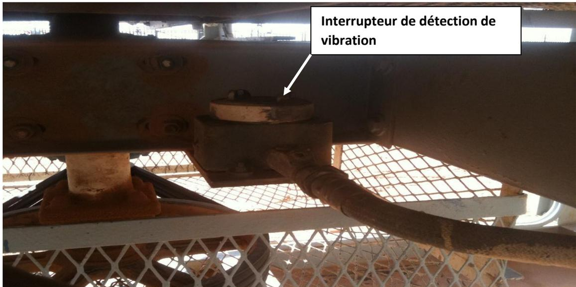
**Figure III.19. Interrupteur de détection de vibration**
