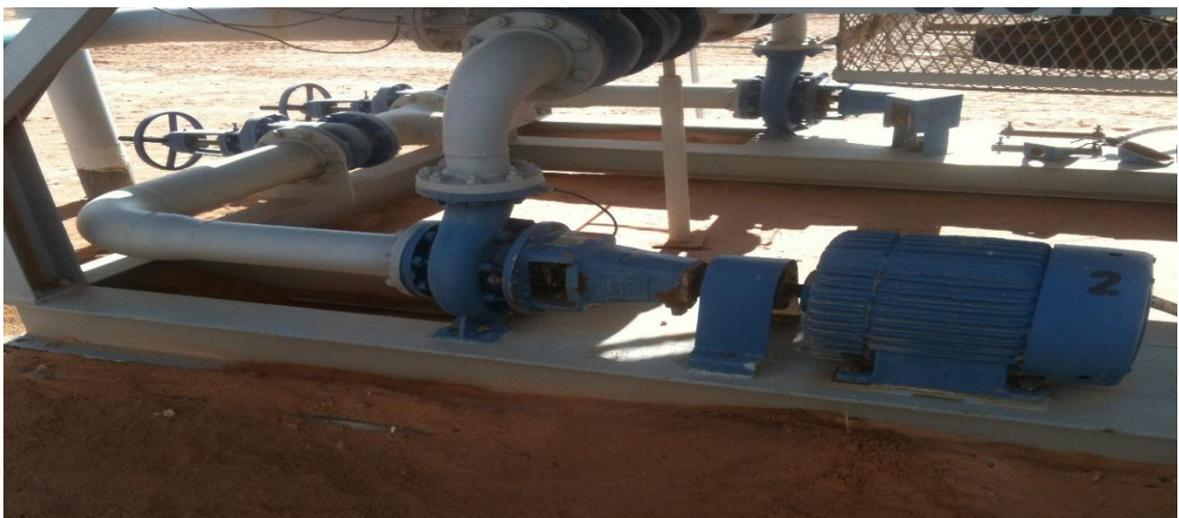
**Figure III.20. Pompe eau de refroidissement**
