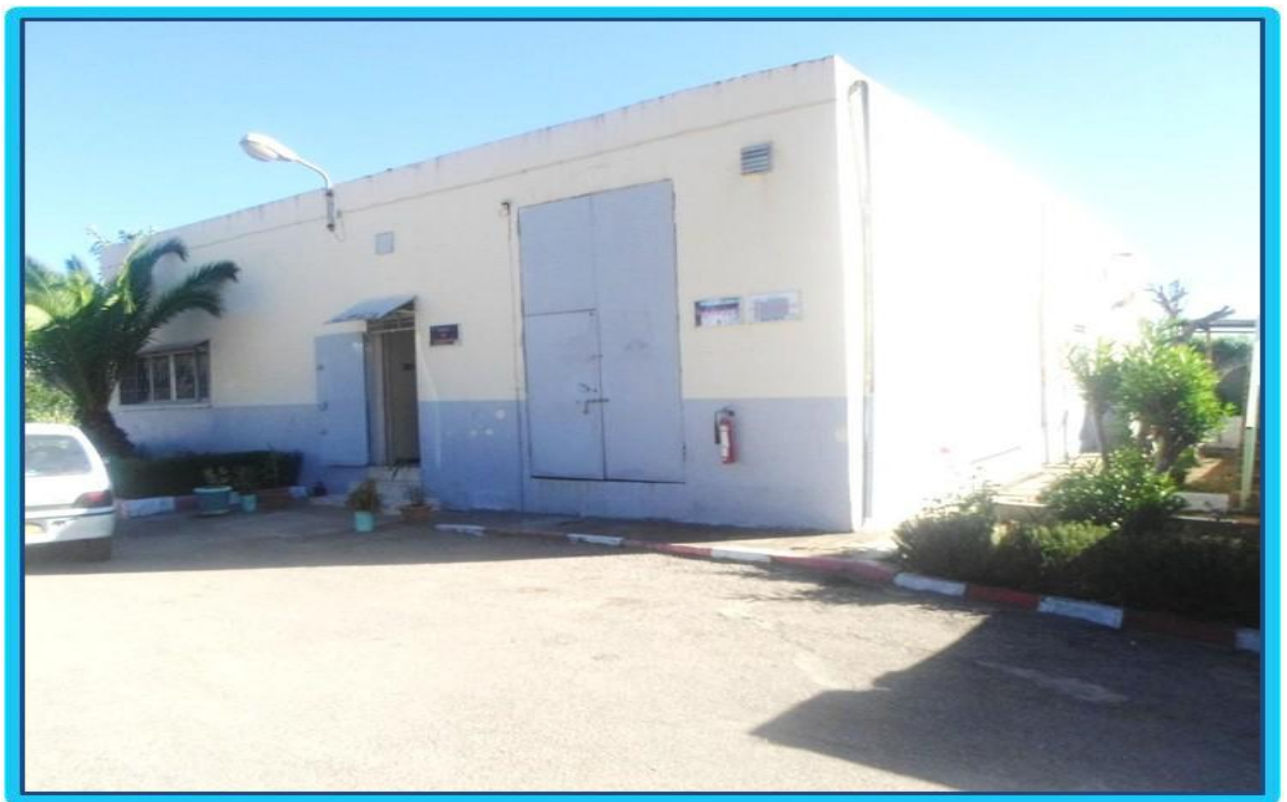
Figure 22 : SALLE DE COMMANDE
