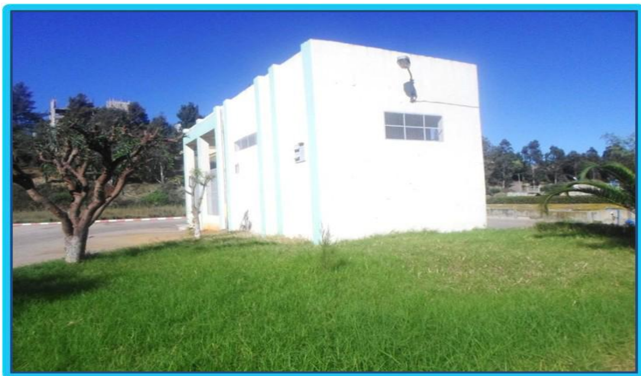
Figure 18 : LOCAL DE CHLORATION
