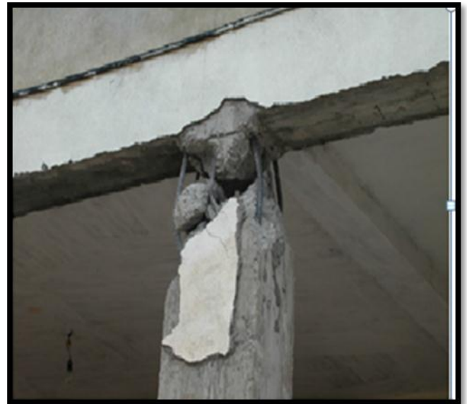
Figure II.7. Flambement d'armatures
