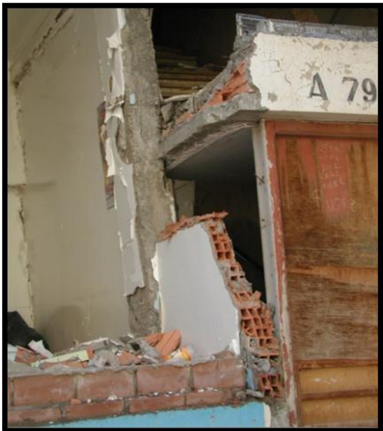
Figure II.9. Rupture de panneaux de maçonnerie intérieures et ceux des façades du RDC.
