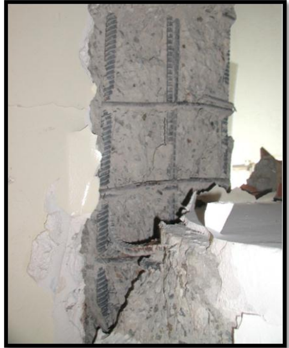
Figure II.8. Eclatement du béton d'enrobage au niveau des zones nodales.
