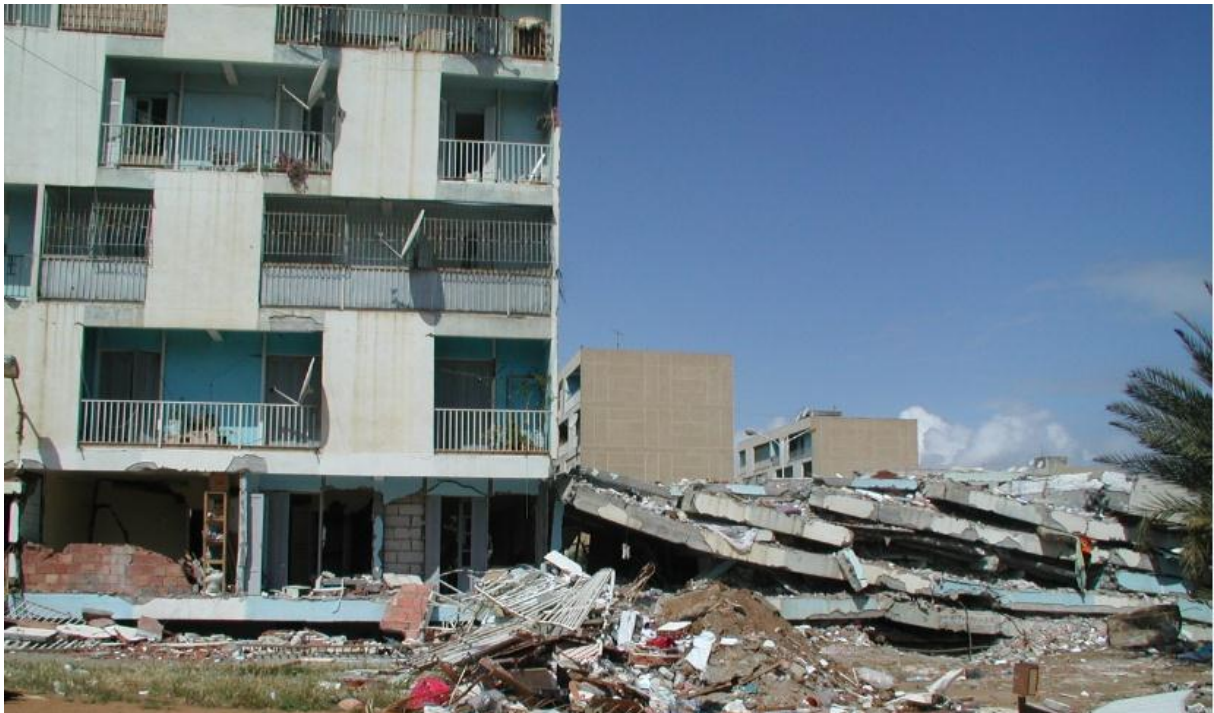
Figure II.11. Étage souple
