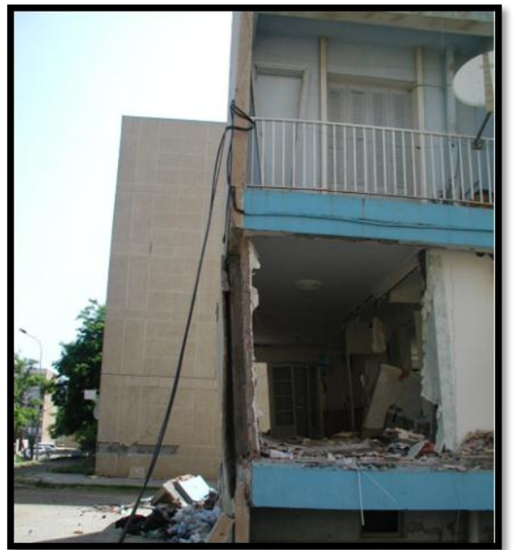
Figure II.9. Rupture de panneaux de maçonnerie intérieures et ceux des façades du RDC.
