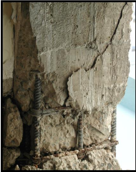
Figure II.8. Eclatement du béton d'enrobage au niveau des zones nodales.
