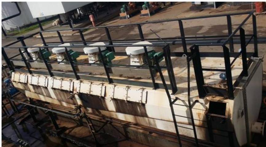
Figure 8 : Système de flottation IGF
