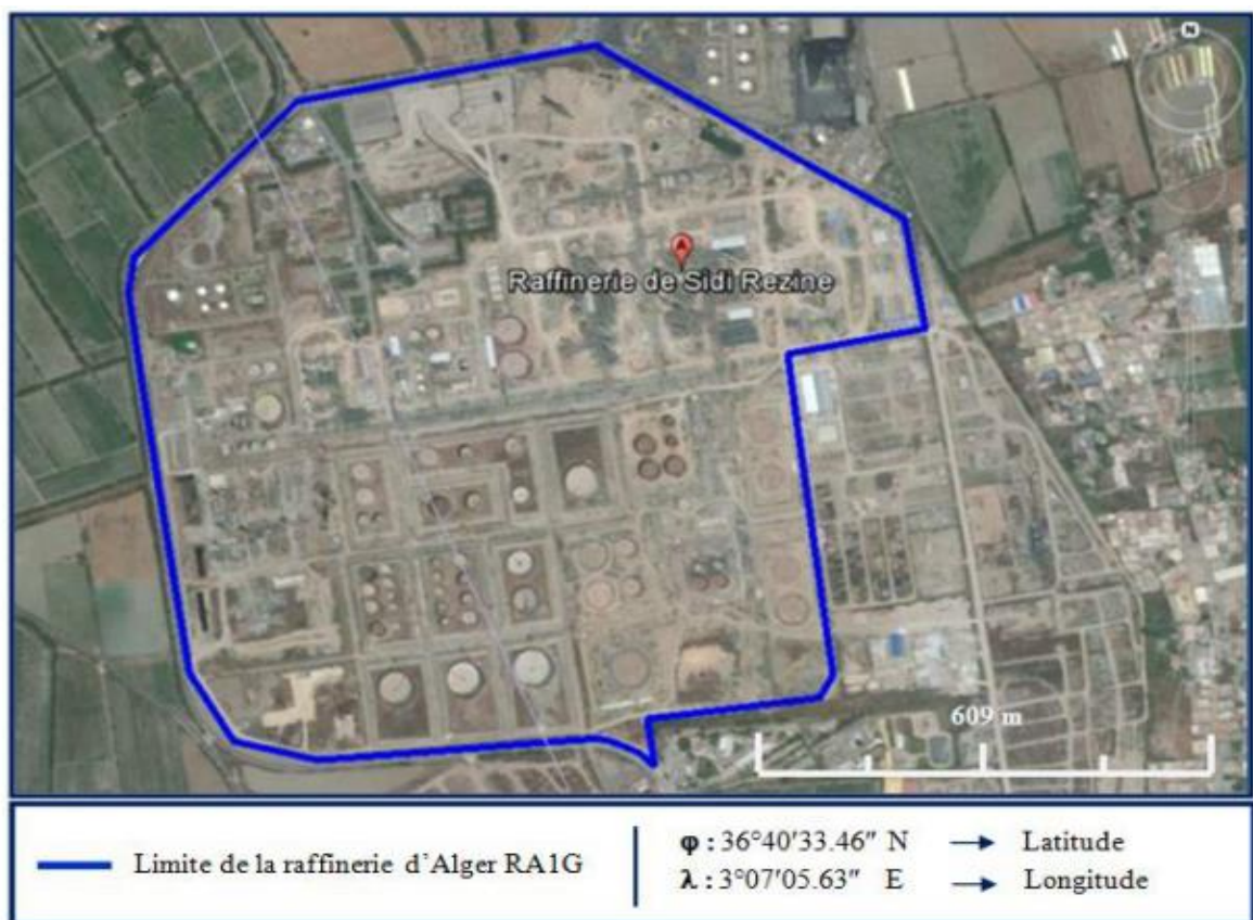
Figure 1 : Vue aérienne de la raffinerie d'Alger (Sidi Rezine) RA1G
