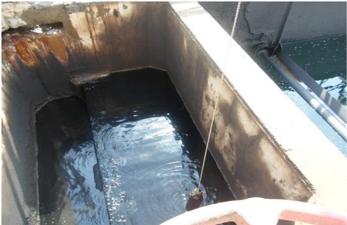
Figure 6 : Prélèvement en amont après l'écumeur au niveau du bassin API.
