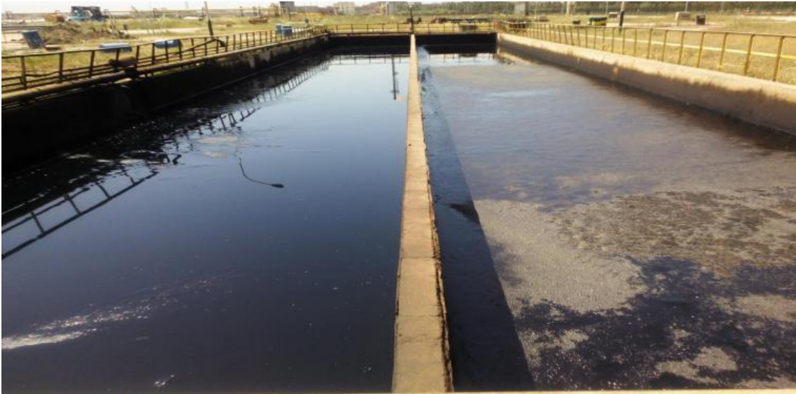
Figure 2: Bassin des eaux huileuses (Bassin de décantation API) de la station de traitement des ERI de la raffinerie d'Alger.
