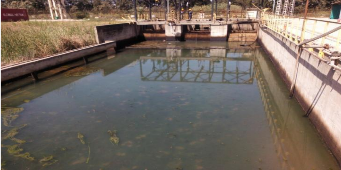
Figure1: Bassin des eaux non-huileuses (pluviales) de la station de traitement de la raffinerie d'Alger.
