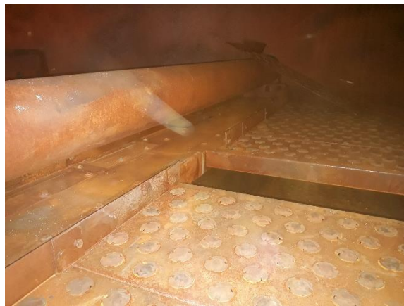
Figure 5.6 : Démontage des plateaux de la colonne C-102
