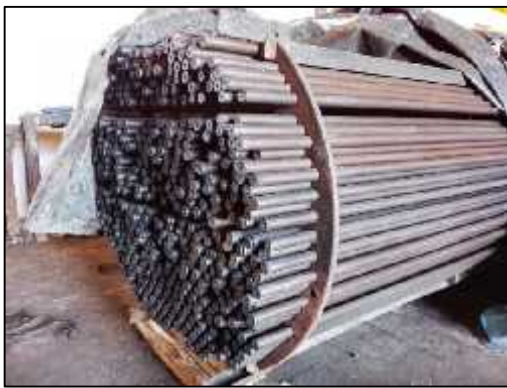
Figure 2.16 : insertion des nouveaux tubes
