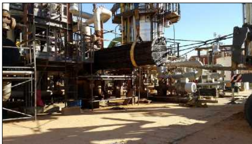
Figure 2.13 : Extraction du faisceau tubulaire en utilisant l'extracteur hydraulique désigné spécialement pour l'extraction des faisceaux tubulaire, avec une grue de 60 tonnes.
