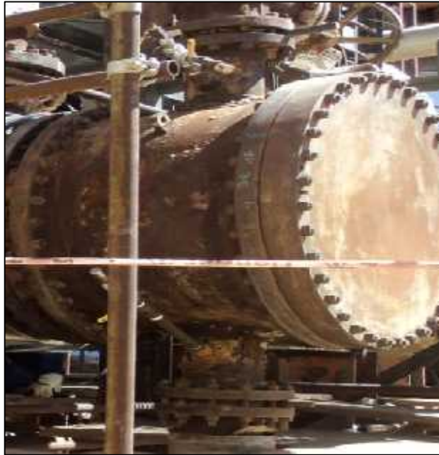
Figure 2.5 : La boîte de distribution de l'échangeur EA4501.
