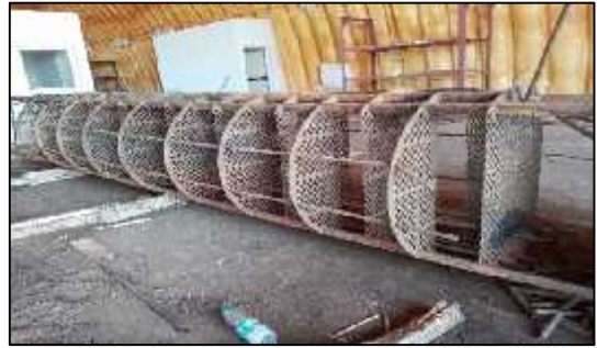
Figure 2.15 : extraction des anciens tubes du faisceau tubulaire
