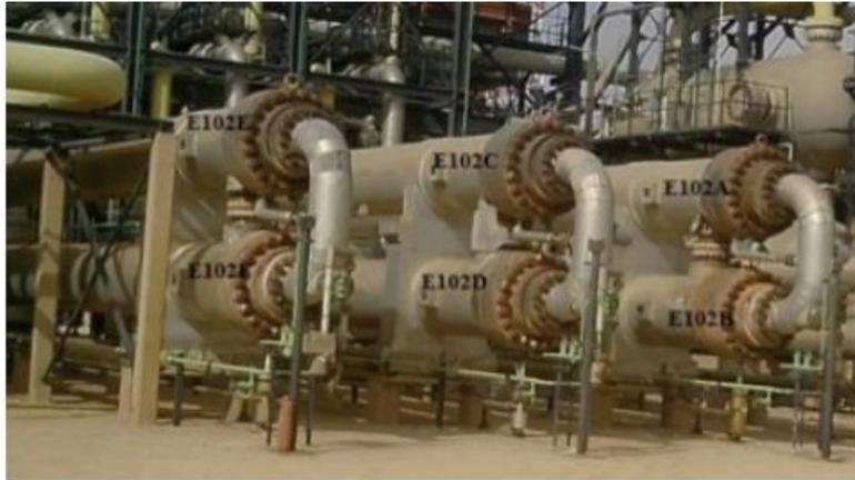
Figure II.23 : Echangeur E102 A/B, C/D, E/F.
