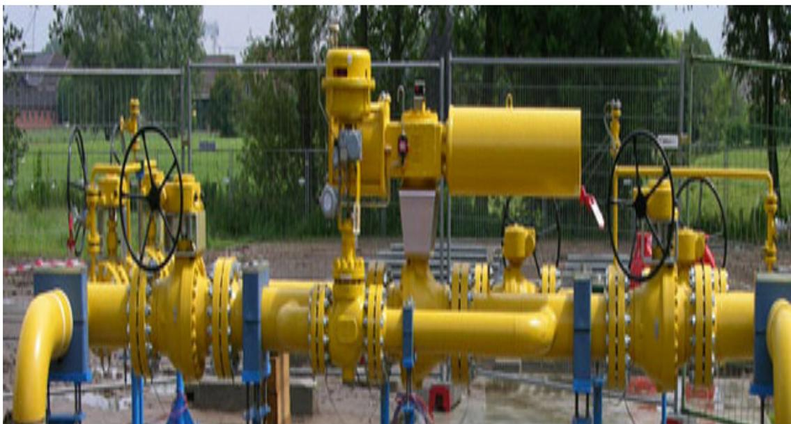
FIGURE 2.5 – Poste de Sectionnement
