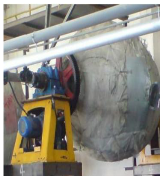
Figure I.9 : Tank ou se déroule le séchage.
