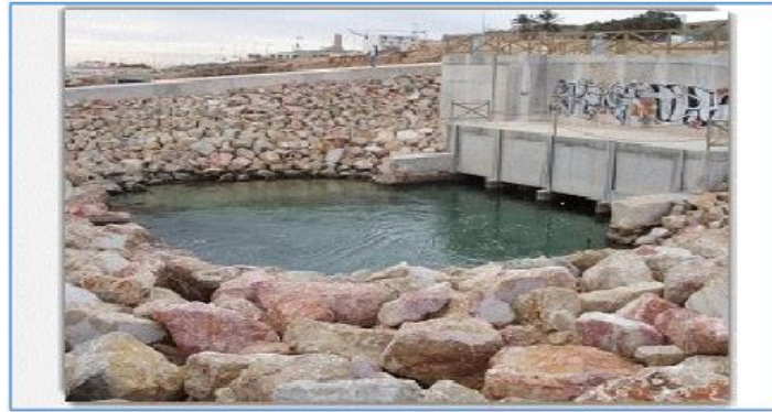
Figure I-15 : Puits côtier en Espagne [45].
