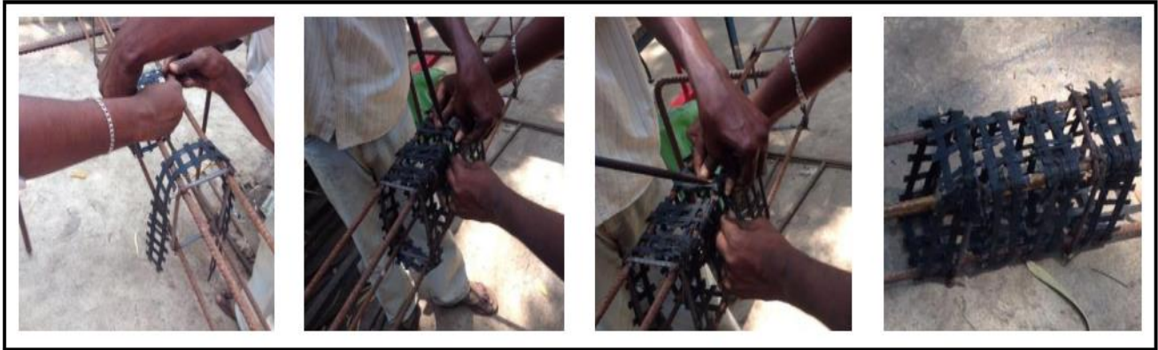
Figure II.28: Renforcement des poutres par géogrille [Sivakamasundari, S et al 2017].
