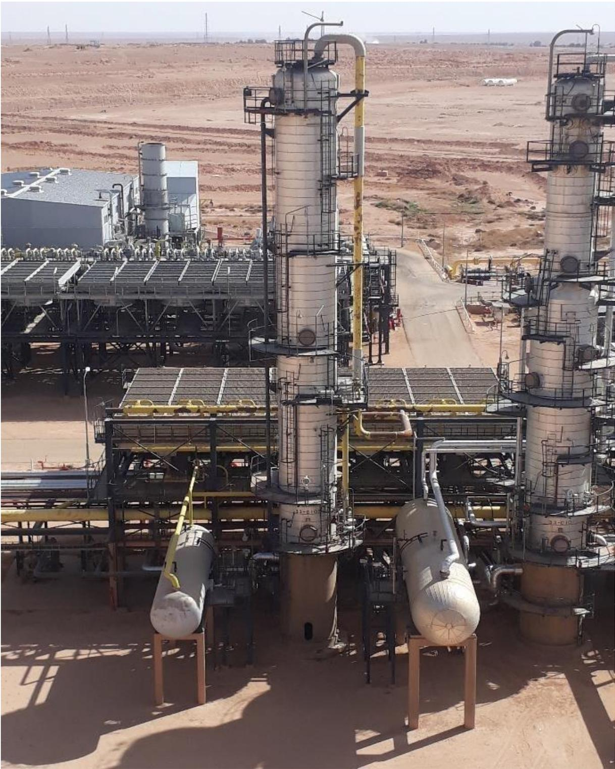
Figure IV. 1 : colonne de distillation
