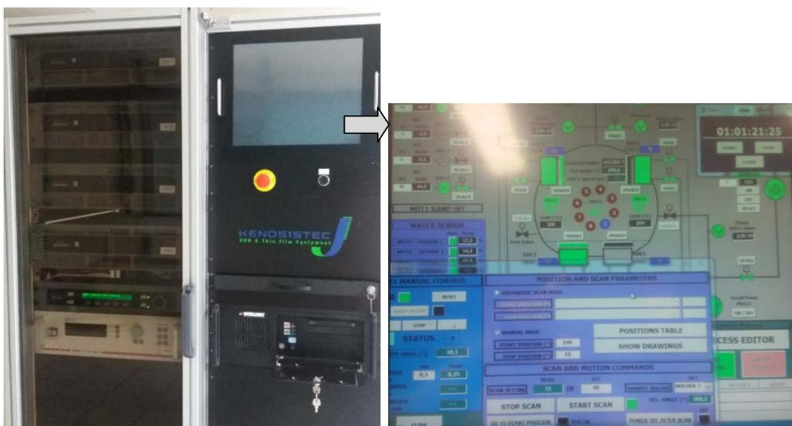
*Figure II.8: Armoire de commande associée à l'interface du PLC (Programmable Logic Controller).*
