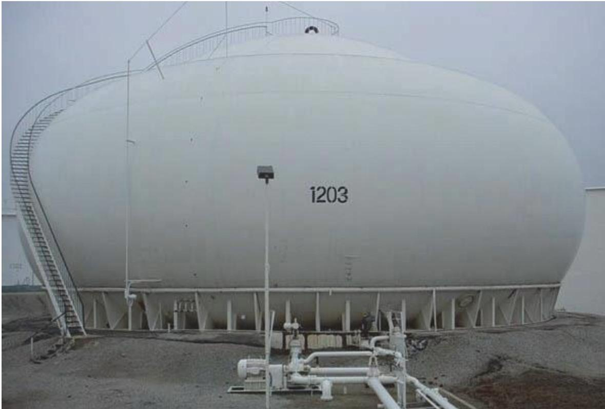
Fig. I.7: Réservoir sphéroïdaux.
