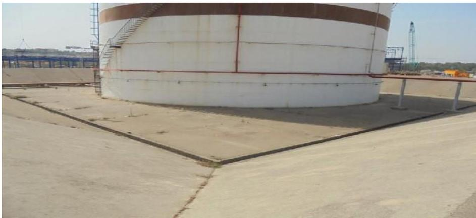
Fig. I.12 : la cuvette de rétention
