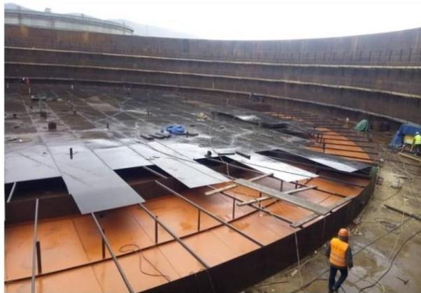
Fig. .Montage de toit
