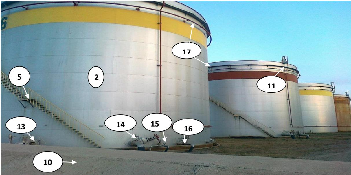
Figure N°6 : Bac -B6- de stockage à toit flottant.
